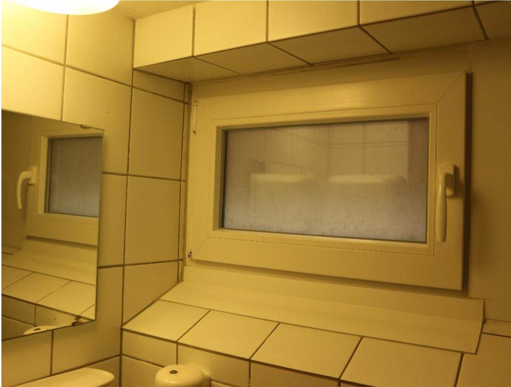
Im Zuge der Sanierung wurden die undichten Fenster im Keller WC durch neue Fensterelemente ersetzt.
