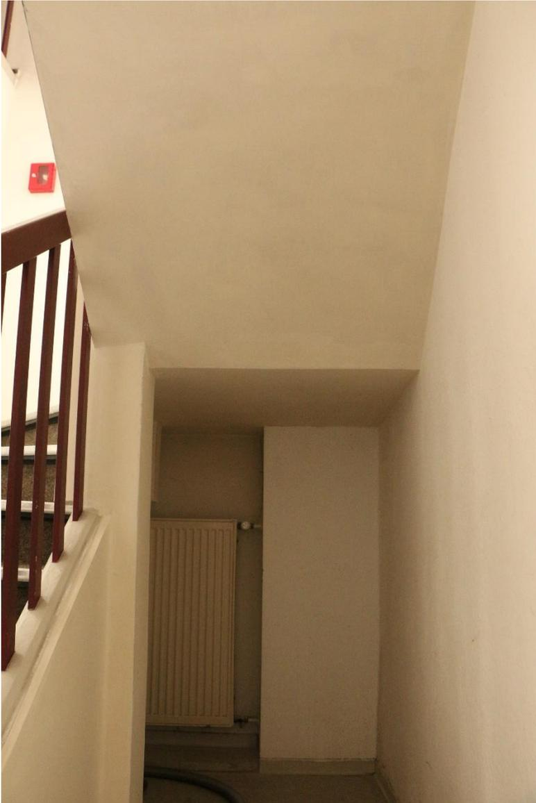
In diesem Zuge wurde das Jugendhaus mit Rauchmeldern ausgestattet und die Holztreppe, die in das 2.OG führt, mit einer Verschalung verkleidet.
