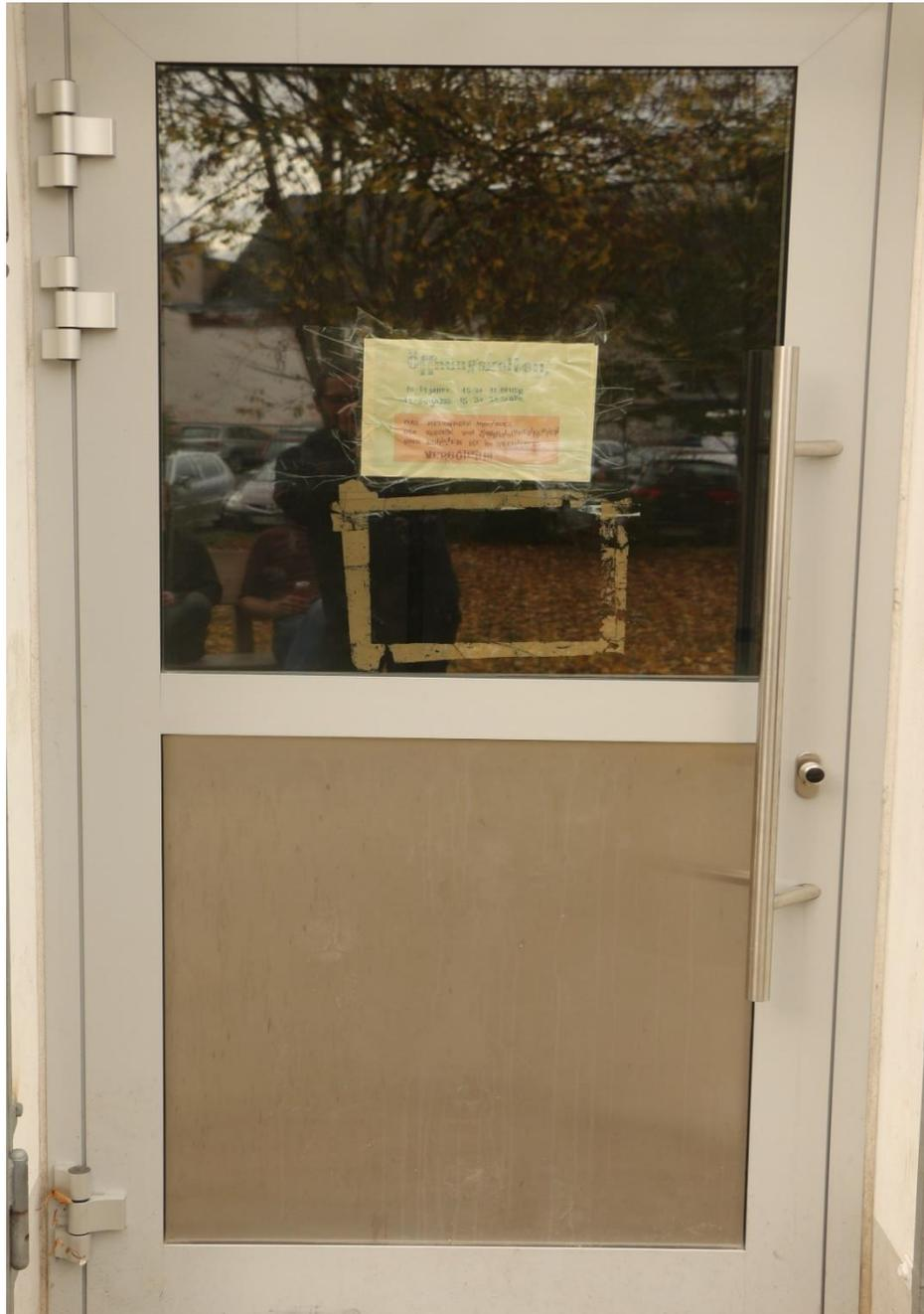
Die Eingangstür des Jugendhauses wurde durch eine neue, stabile Eingangstür ersetzt und das Eingangstürschloss mit einer mechatronischen Schließanlage ausgestattet.
