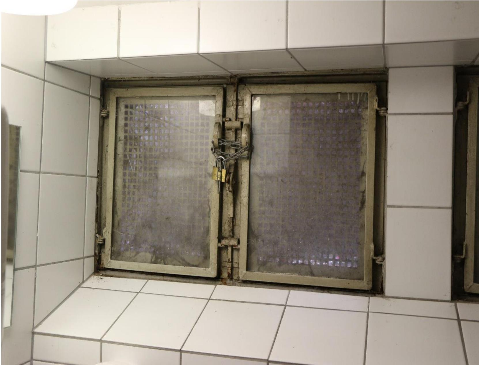
Vor der Sanierung kam es, aufgrund eines nicht mehr verschließbaren Fensters, zu einem starken Wassereintritt. Auch konnte das Fenster nur noch mit einem Kettenschloss verschlossen werden.
