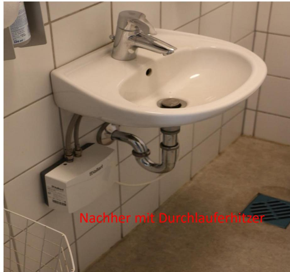
Um der Lebensmittelhygieneverordnung vollständig folgen zu können, wurde im Personal-WC (1. OG) ein Durchlauferhitzer angebracht, damit die Hände mit Warmwasser gereinigt werden können.
