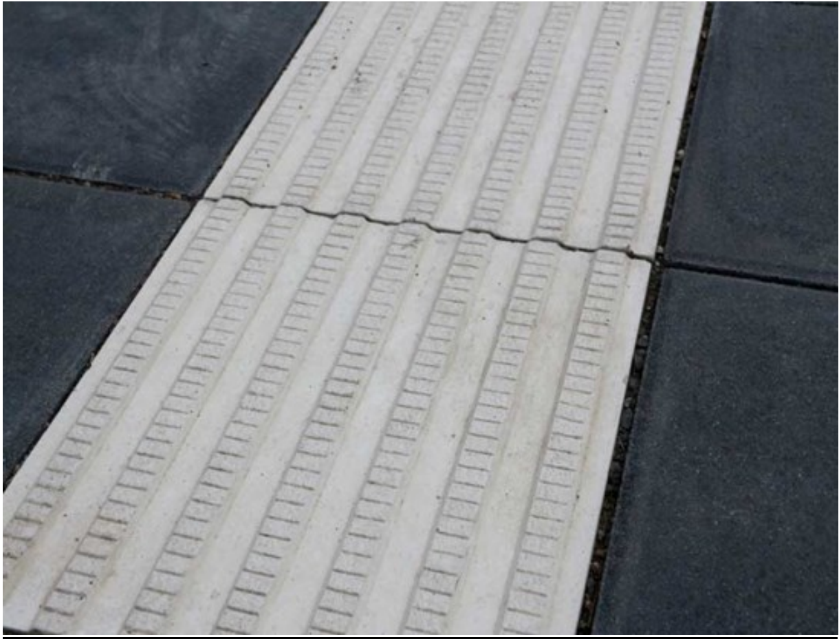
Beispielfoto Blindenleitelement als Rillenplatte nach DIN 32984.
