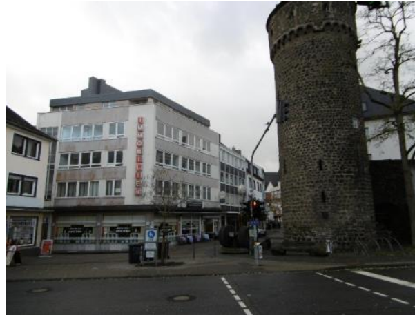
Mühlenturm, Innenstadtzugang Markstraße am Habsburging
