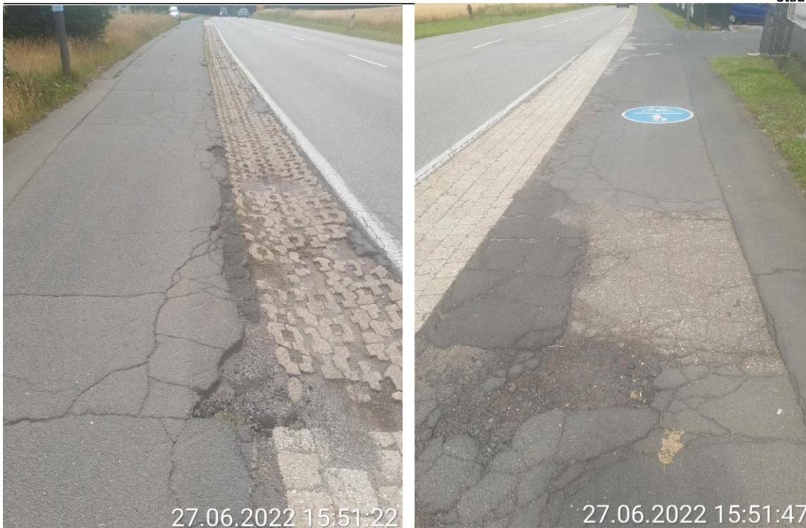
Abbildung 7 & 8: Defekte Rinne entlang L98 & Schäden im Bereich Zufahrt ED Baucenter
