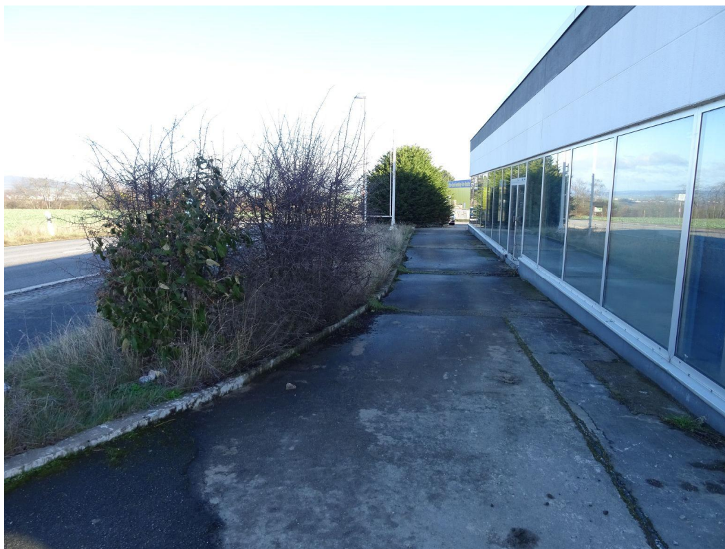
Foto 3 Blick nach Osten entlang der L 98
