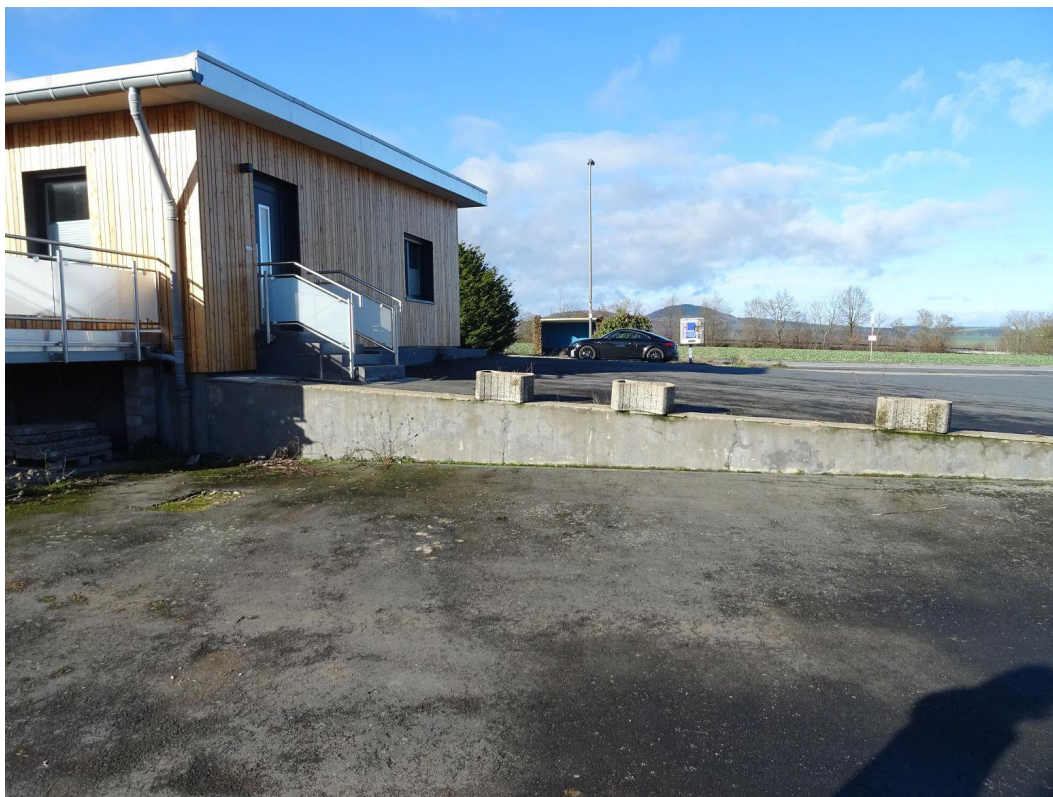
Foto 2 Blick nach Norden über den Parkplatz an der Einfahrt „Am Sürchen“
