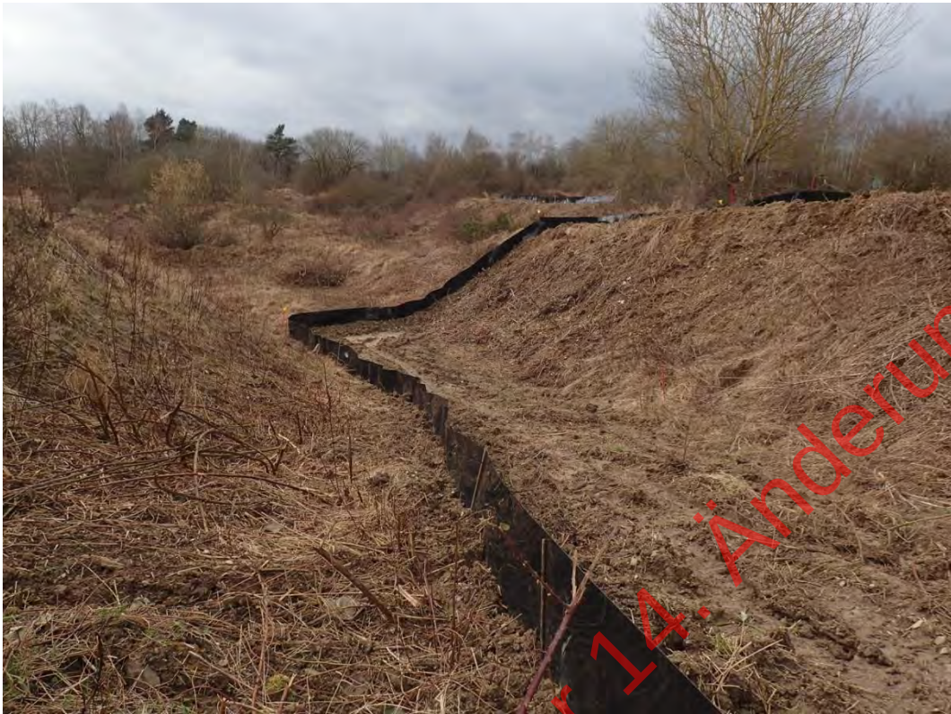
Bild 16: Fertig gestellte Rhizomsperre im Grubenbereich (24.02.2022)
