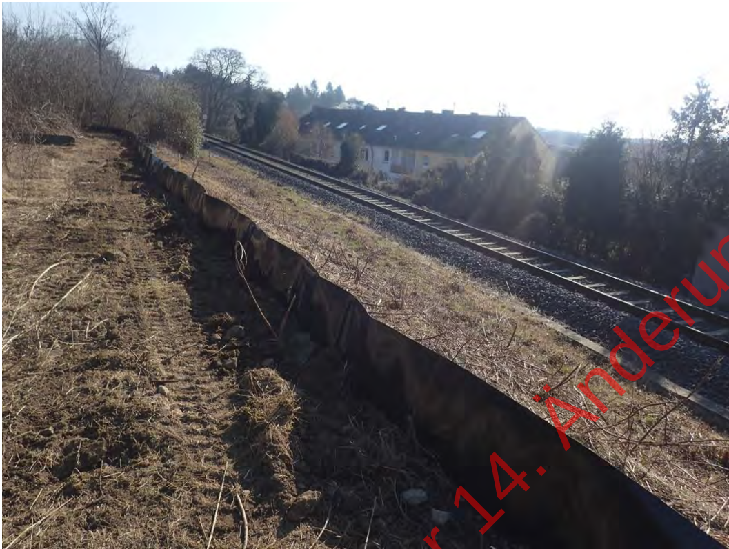
Bild 05: Abzäunung des Eingriffsgebiets (10.03.2022)
