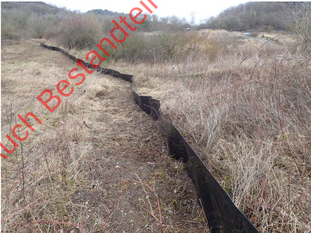
Bild 17: Fertig gestellte Rhizomsperre auf dem Deponiegelände (24.02.2022)
