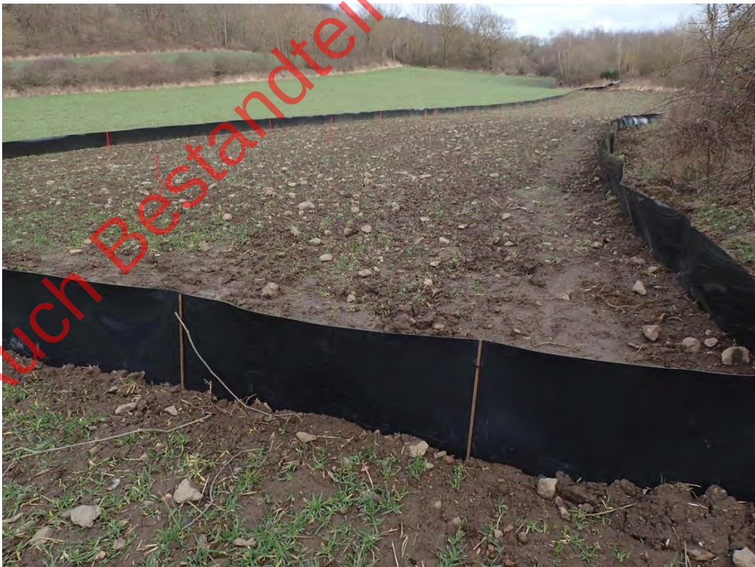
Bild 15: Fertig gestellte Rhizomsperre auf der Ackerfläche (24.02.2022)
