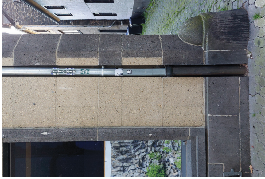
Abb. 27 Präzise Durcharbeitung bis ins Detail: Wiederaufbauarchitektur in der Brückenstraße. Die Fallrohre sind in eine Nische fassadenbündig eingesetzt, die Außenecke des Basaltlava-Sockels ist mit einem Prellstein akzentuiert und zugleich geschützt. Die Mauerwerkfugen sind farblich an die Tuffsteinflächen angeglichen, wodurch sich ein reizvoller Kontrast zu den dunklen Basaltlavasteinen ergibt. Das Straßenpflaster besteht ebenfalls aus Basaltlava, wodurch sich eine Verbindung zum Gebäudesockel ergibt.
