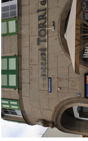
Abb. 40 Der überzeugend wirkende Schriftzug aus Einzelbuchstaben wird nachts hinterleuchtet. Die Balance aus Einfügung und Wahrnehmbarkeit ist hier gelungen: Der gut lesbare Schriftzug verdeckt die historische Tuffstein-Fassade nicht. Er ist auf einer Schiene montiert, die sich optisch unterordnet, weil sie in einem fassadenähnlichen Farbton lackiert ist.
