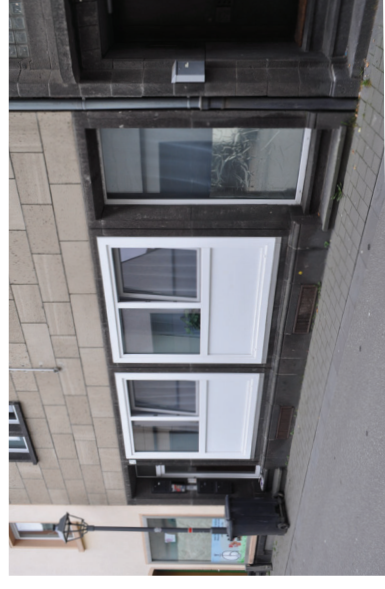
Abb. 52 Hier wurde das Erdgeschoss zu Wohnzwecken umgenutzt. Um dem verständlichen Bedürfnis nach Privatsphäre gerecht zu werden, wurden neue Fenster mit Brüstungen eingesetzt. Eine massiv gemauerte Brüstung aus Basaltlava hätte sich in die hochwertige Naturstein-Fassade besser eingefügt. Die frühere Laden-Eingangstür ist mit Spiegelfolie bis in Brüstungshöhe abgeklebt, was keine dauerhafte Lösung darstellen kann.
