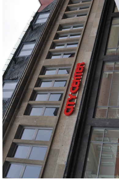
Abb. 41 Bestechend einfach und minimalistisch gehalten, präsentiert sich dieser Schriftzug am früheren Kaufhof-Gebäude am Marktplatz. Auch hier sind die Buchstaben auf Schienen montiert, um die Tuffstein-Fassade zu schonen.
