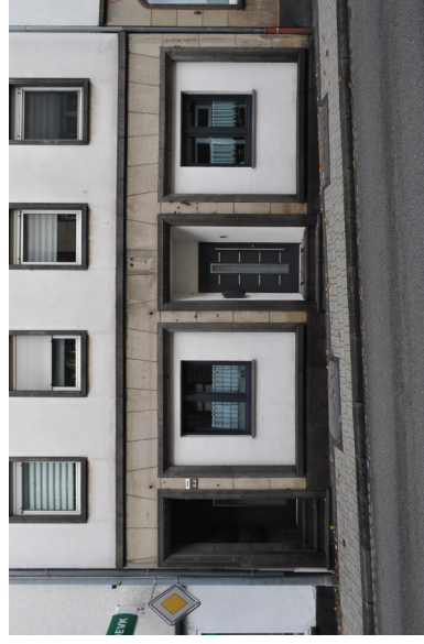
Abb. 50 Die neuen Fenster sind deutlich kleiner sind als die früheren Schaufenster und sitzen deshalb etwas verloren in den weiß verputzten Flächen. Auch die neue Tür füllt den alten Türrahmen aus Basaltlava nicht aus. Es wäre gestalterisch überzeugender und würde auch die Belichtung der Räume verbessern, wenn die neuen Öffnungen die volle Breite der alten Schaufenster aufweisen würden.
