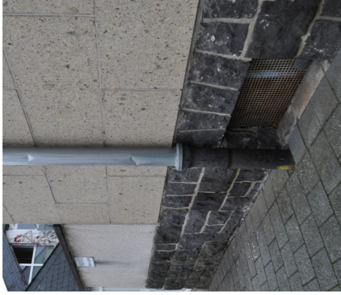
Abb. 26 Der Übergang zwischen dem dunklen gusseisernen Standrohr und hellerem dachdeckermäßigem Fallrohr aus Titanzink ist präzise auf den Gebäudesockel aus Basaltlava bezogen.
