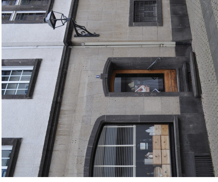
Abb. 17 Sockel und Gesims aus Basaltlava rahmen die mit Tuffstein verkleidete Erdgeschosszone. Die Tür- und Fenstergewände aus Basaltlava sind aufwändig steinmetzmäßig bearbeitet und sehr differenziert ausgeführt. Hier sind die Obergeschosse verputzt ausgeführt. Der mutmaßlich ursprünglich nicht farbig gefasste Putz wurde nachträglich weiß gestrichen.
