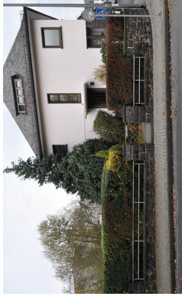
Abb. 123 Gestalterische Einheit aus Einfriedung und Gebäudearchitektur bei einem Wohnhaus in der Straße Im Trinnel in Mayen. Die Einfriedung besteht aus einem aus Basaltlava gemauerten Sockel und handwerklich gefertigten bekrönenden Gittern aus weiß lackiertem Stahl sowie dahinter gepflanzten Hecken. Basaltlava und Dachschiefer binden die Gesamtanlage optisch zusammen.
