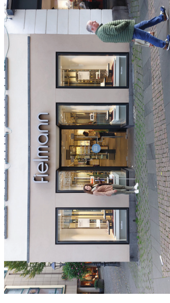
Abb. 102 Modernes Mayener Schaufenster in der Marktstraße mit Adaption des traditionellen Basaltlava-Sockels. Die Pfeiler-Gliederung ist auf den Rhythmus der Öffnungen in den Obergeschossen bezogen.
