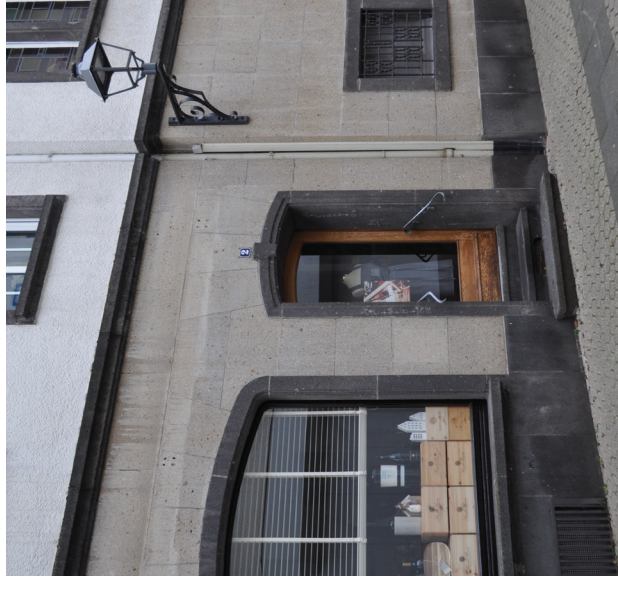
Abb. 113 Typische Mayener Fassadenmaterialität: Sockel und Gesims aus Basaltlava, die Erdgeschosszone in Tuffstein verkleidet. Alle Tür- und Fenstereinfassungen sind aus Basaltlava und aufwändig steinmetzmäßig bearbeitet. Die Fassadenflächen in den oberen Geschossen sind weiß verputzt und weiß gestrichen.
