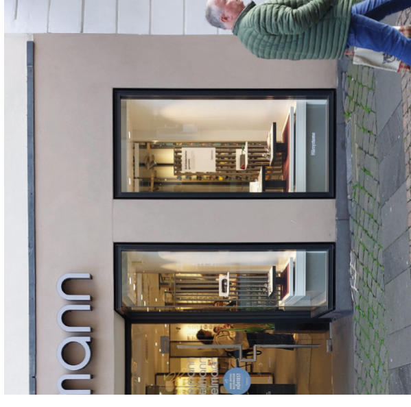
Abb. 116 Zurückhaltende, ortssensible Verwendung von Materialien an einem Geschäftshaus mit Ladenlokal in der Mayener Markstraße: Der Sockel ist aus Basaltlava, die Rahmen der Schaufensteranlage aus dunkel beschichtetem Metall. Die Fassadenflächen sind hell verputzt, wobei das Erdgeschoss dezent farblich abgesetzt ist. Diese Zonierung der Erdgeschossfassade nimmt Bezug auf örtliche Bautraditionen.
