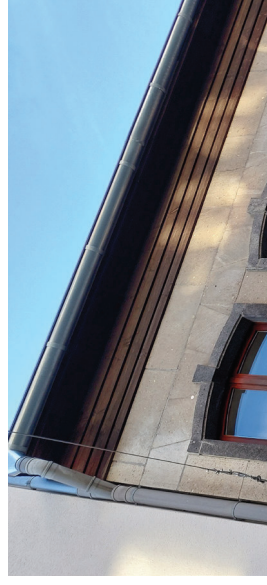
Abb. 119 Farbig gefasstes, hölzern verkleidetes Traufgesims
