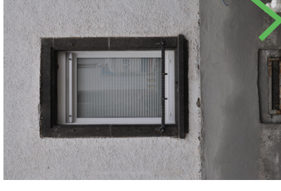
Abb. 99 Rollladenkasten fassadenbündig eingebaut
