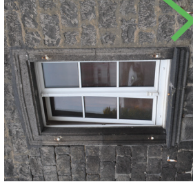
Abb. 92 Denkmalsprossen, historisch korrekt zweiflügelig, mittiger echter Pfosten, insgesamt stimmiges Bild
