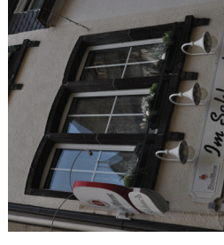
Abb. 95 Die Sprossen sorgen zwar für etwas Belebung. Weil sie aber als „Sprossen in Asplik“ ausgeführt sind und der Rahmen nicht der Bogenform folgt, entsteht ein unbefriedigender Gesamteindruck.
