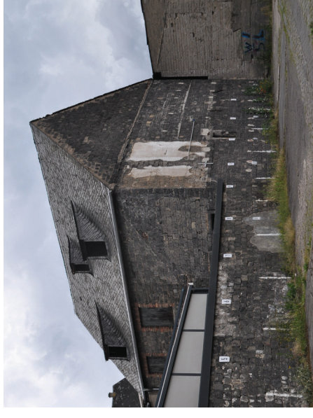
Abb. 58 Charakteristische geringe Dachüberstände an Traufe und Ortgang bei einem historischen Altstadt-Gebäude im Mühlenweg 17. Foto: Johannes Buchhammer, Oktober 2024
