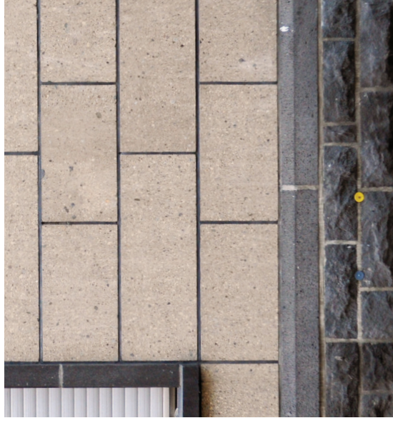
Abb. 115 Sockel und Fenstereinfassungen aus Basaltlava, Fassadenflächen aus Tuffstein, Fugen jeweils kontrastierend zum umgebenden Naturstein
