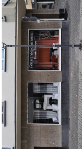
Abb. 101 Schaufenster in einem Gebäude der Nachkriegs-Wiederaufbauarchitektur mit Mayen-typischer Materialität: Sockel aus Basaltlava, Fassaden aus Weiberner Tuff, weiße Fensterrahmen. Mayen, Göbelstraße.
