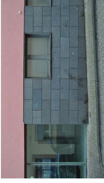
Abb. 114 Moderne Adaption typischer Mayener Materialien: Basaltlava-Platten als vorgehängte Fassade im Bereich des Erdgeschosses bei einem Bürogebäude. Fassade in der Straße Bornhaustert/Ecke Töpferstraße, Mayen.
