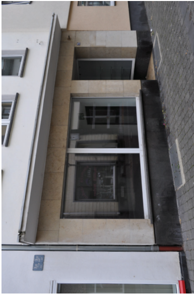
Abb. 84 Ein typisches Mayener Kragdach: ca. 50 cm tief, ca. 15 cm stark. Foto: Johannes Buchhammer, 26. Oktober 2024
