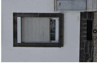
Abb. 97 Außen aufgesetzter Rollladenkasten
