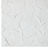
Putz mit leichtem Kellenstrich
