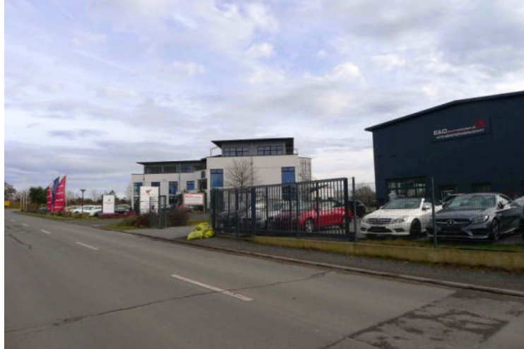
Abbildung 22: Blick auf die gewerblich genutzten Grundstücke am 'Kottenheimer Weg'
