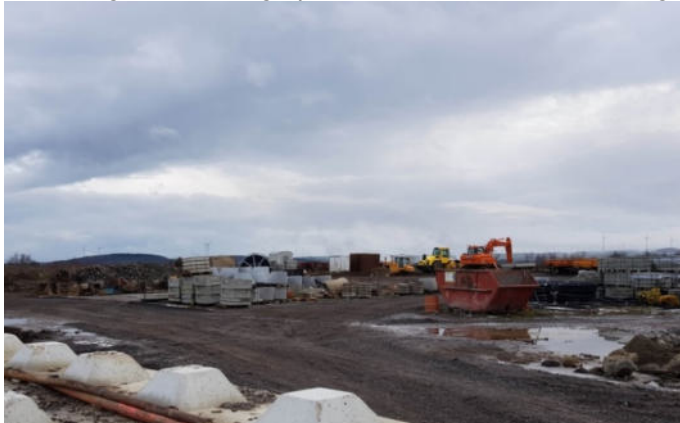
Abbildung 25: Lagerplatz/ Bauhof südlich des Plangebiets
