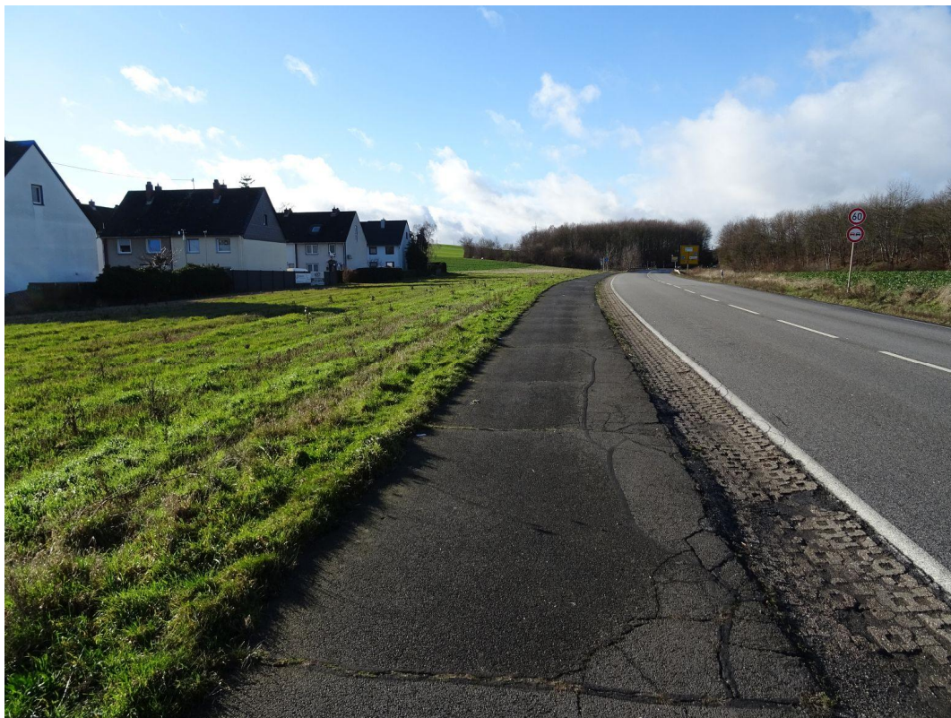
Foto 4 Blick nach Westen entlang der L 98
