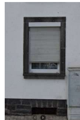
Abb. 97 Außen aufgesetzter Rollladenkasten
