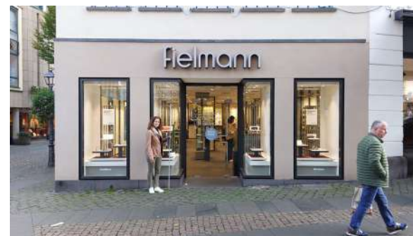
Abb. 102 Modernes Mayener Schaufenster in der Marktstraße mit Adaption des traditionellen Basaltlava-Sockels. Die Pfeiler-Gliederung ist auf den Rhythmus der Öffnungen in den Obergeschossen bezogen.
