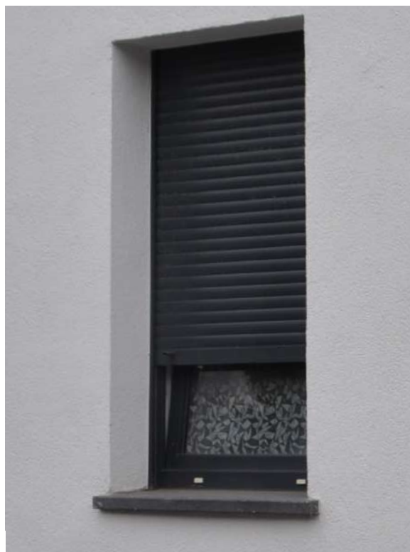
Abb. 32 Die Fensterbank aus Basaltlava passt gut nach Mayen, dunkle Fensterrahmen sind aber nicht ortstypisch.
