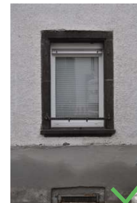
Abb. 99 Rollladenkasten fassadenbündig eingebaut
