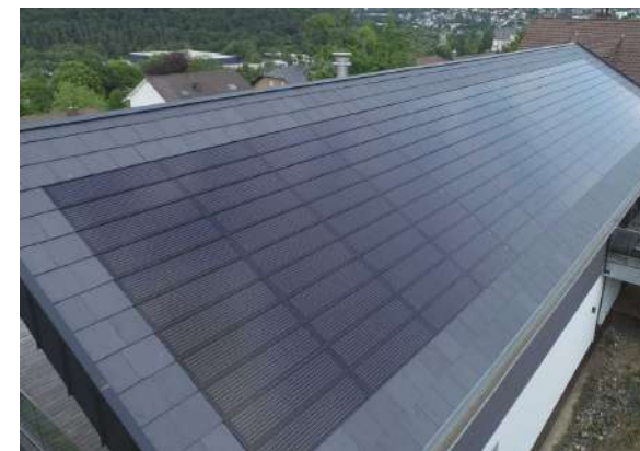
Abb. 71 Eine interessante neue Entwicklung, die gestalterisch überzeugt: Dacheindeckung ersetzende Solarmodule, eingebettet in ein Schieferdach mit horizontaler bzw. Rechteck-Doppeldeckung.
