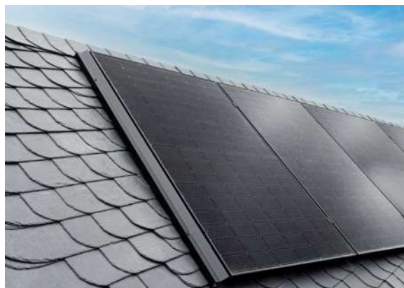
Abb. 69 Aufdach-Photovoltaikanlage. Solche Anlagen können nachträglich auf Schieferdächer aufgebracht werden.
