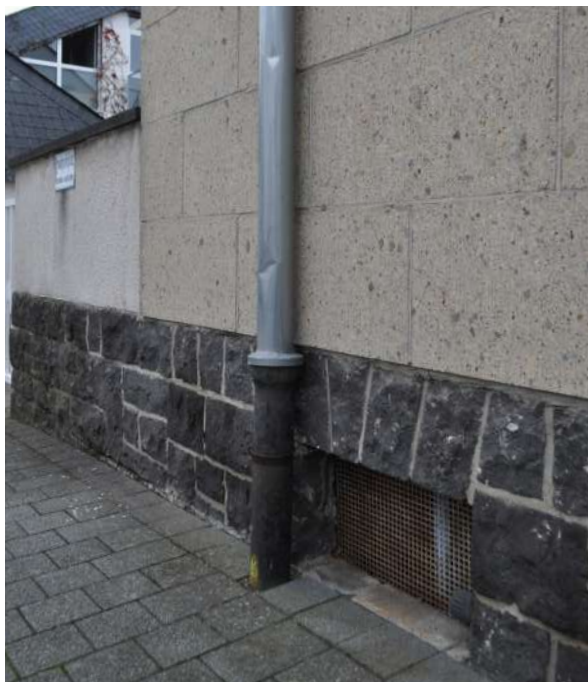
Abb. 26 Der Übergang zwischen dem dunklen gusseisernen Standrohr und hellerem dachdeckermäßigem Fallrohr aus Titanzink ist präzise auf den Gebäudesockel aus Basaltlava bezogen.
