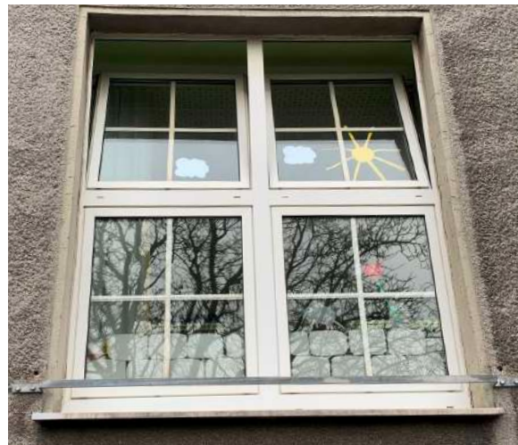
Abb. 29 Innenliegende Sprossen (oder „Sprossen in Aspik“) kommen bei Streulicht nicht genug zur Geltung. Sie weichen vom handwerklichen historischen Vorbild ab und sollten daher in der historischen Innenstadt nicht verwendet werden.
