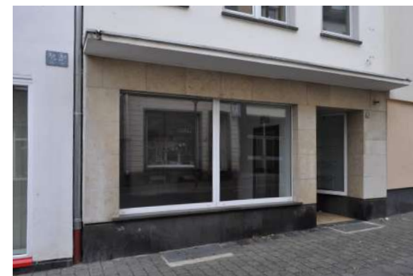
Abb. 84 Ein typisches Mayener Kragdach: ca. 50 cm tief, ca. 15 cm stark. Foto: Johannes Buchhammer, 26. Oktober 2024
