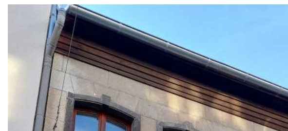
Abb.119 Farblich gefasstes, hölzern verkleidetes Traufgesims
