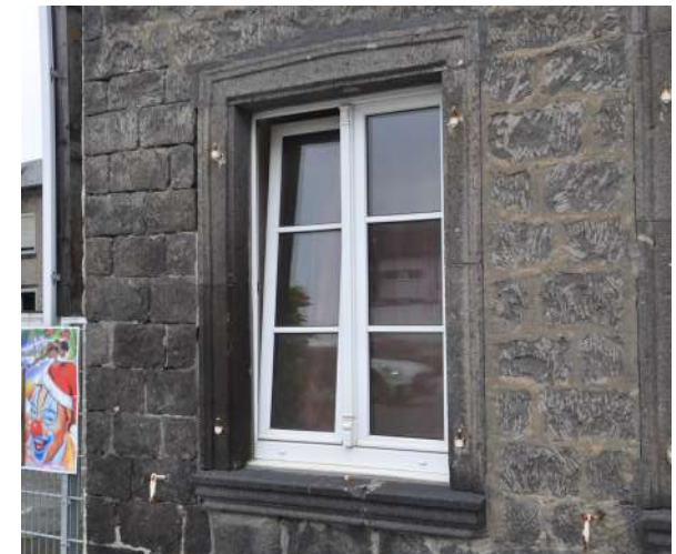
Abb. 31 Dieses Fenster ist historisch korrekt zweiflügelig und mit Sprossung ausgeführt. Derart überzeugende Ergebnisse lassen sich sowohl in Holz als auch Kunststoff erreichen, sofern auf schmale Fensterprofile geachtet wird.
