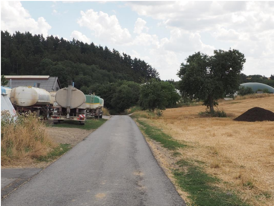
Abbildung 6: bituminös befestigter Erschließungsweg zur Biogasanlage
