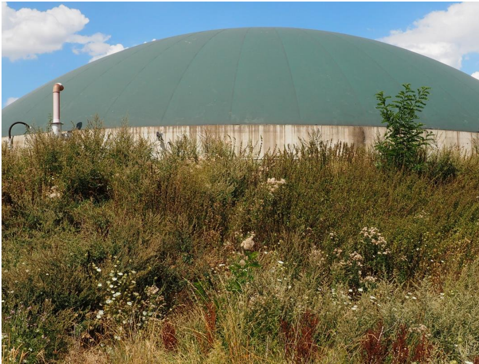
Abbildung 10: Blick auf die randliche Eingrünung der Gärbehälter 3
