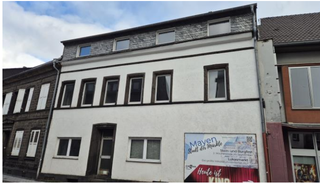
Abbildung 2: Frontansicht des betroffenen Gebäudes
