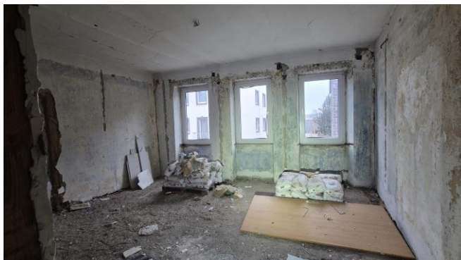
Abbildung 5: Blick ins Obergeschoss
