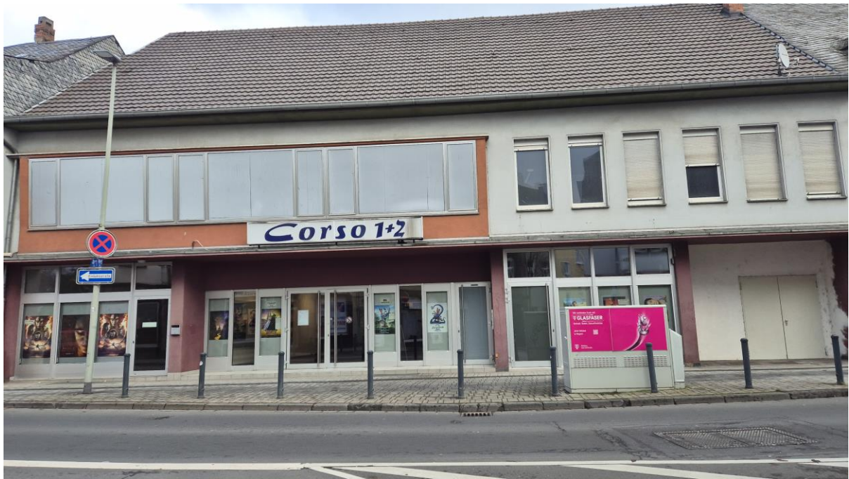
Abbildung 15: Blick auf die für das Anbringen der Fledermaus- und Nistkästen vorgesehene Fassade des „Corso“. Links ist das vom Vorhaben betroffene Gebäude zu sehen
