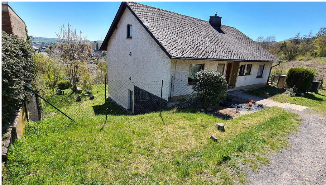
Foto Nr. 2 Blick auf das Wohngebäude Königsbergstraße 21 nach Südwesten
