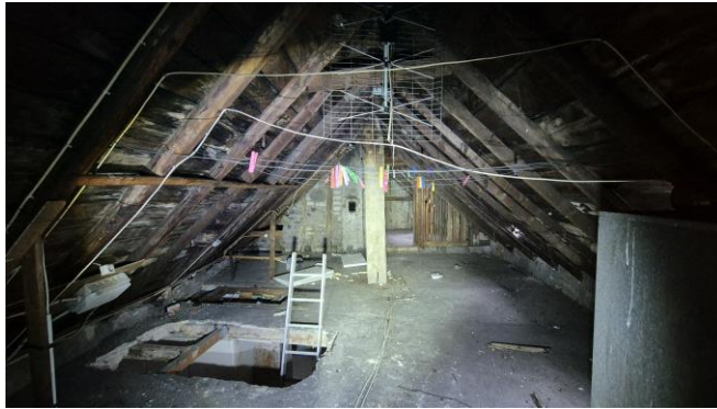
Abbildung 6: Blick in den Dachstuhl
