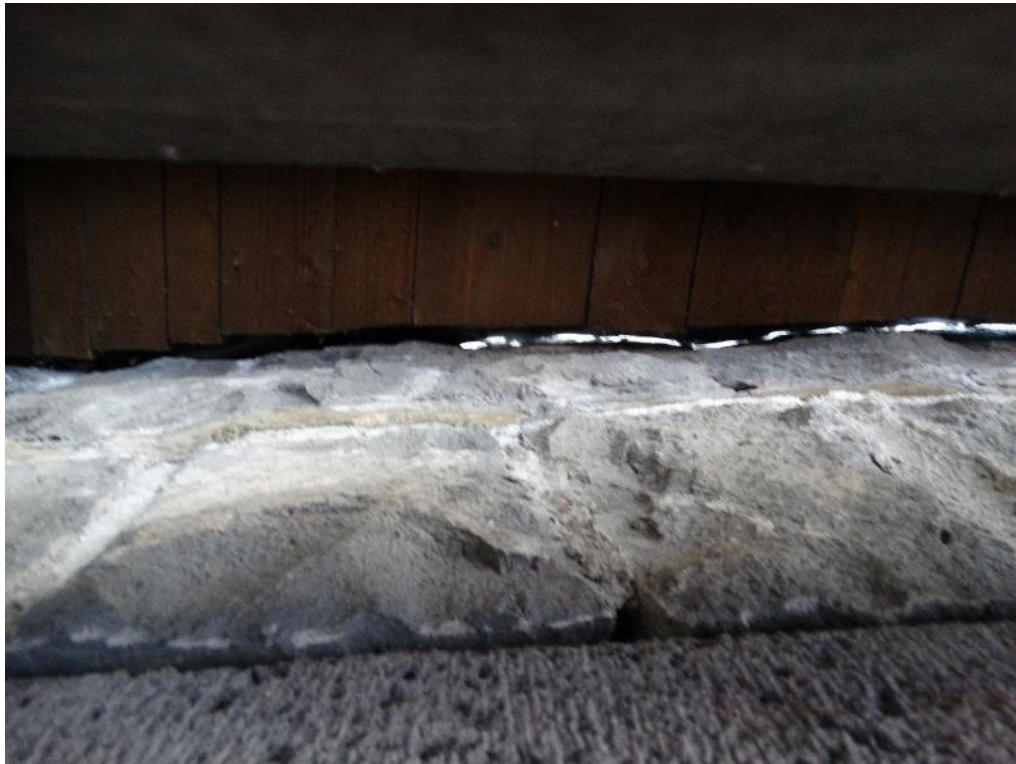
06. Foto vom 19.02.2025 Anschluss Pulldach an Wehrturm
