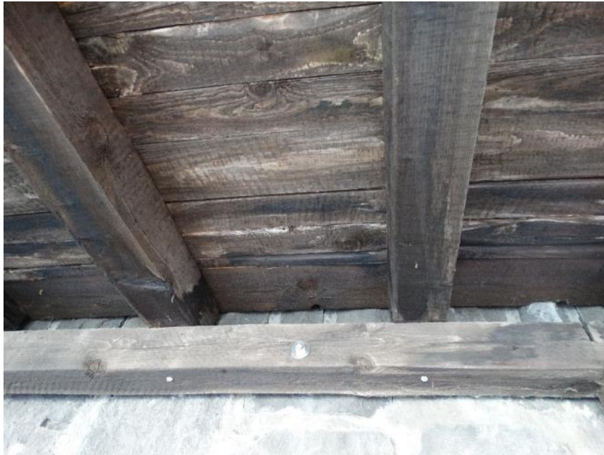
08. Foto vom 19.02.2025 Anschluss Pultdach an Mauer
