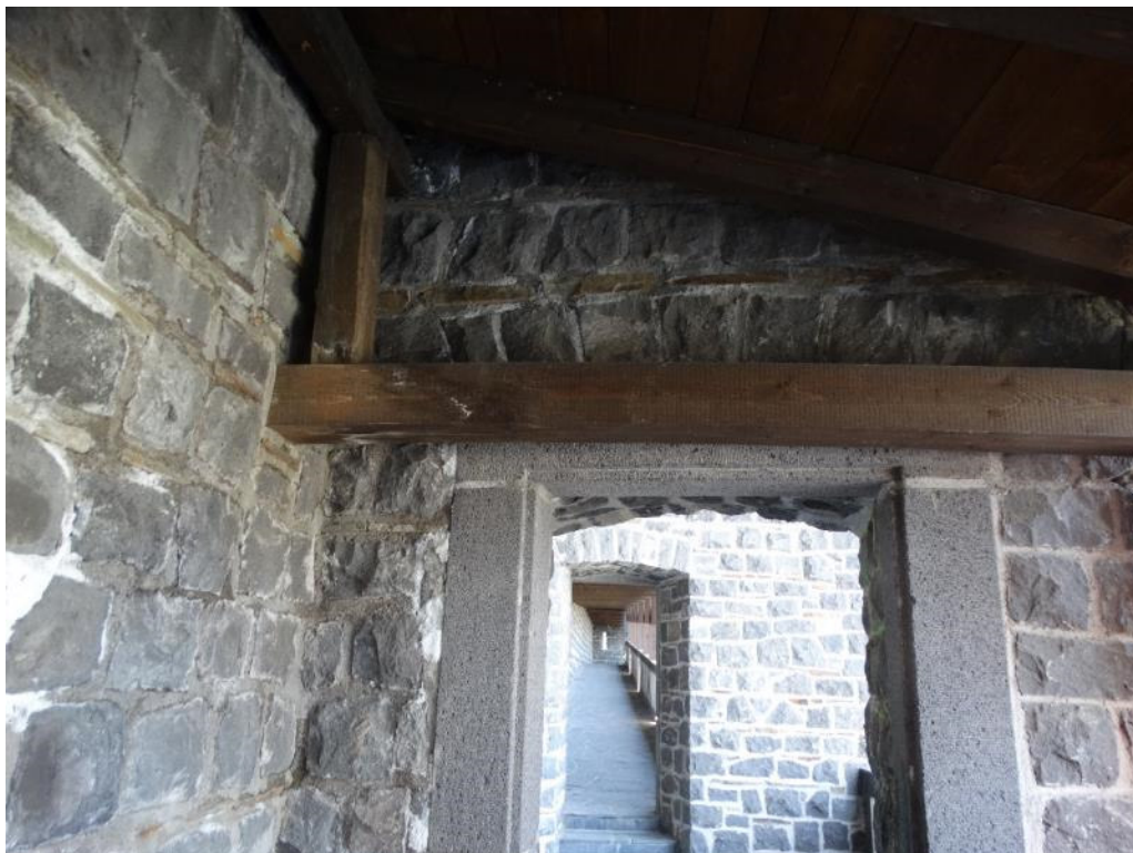
07. Foto vom 19.02.2025 Anschluss Pulldach an Wehrturm
