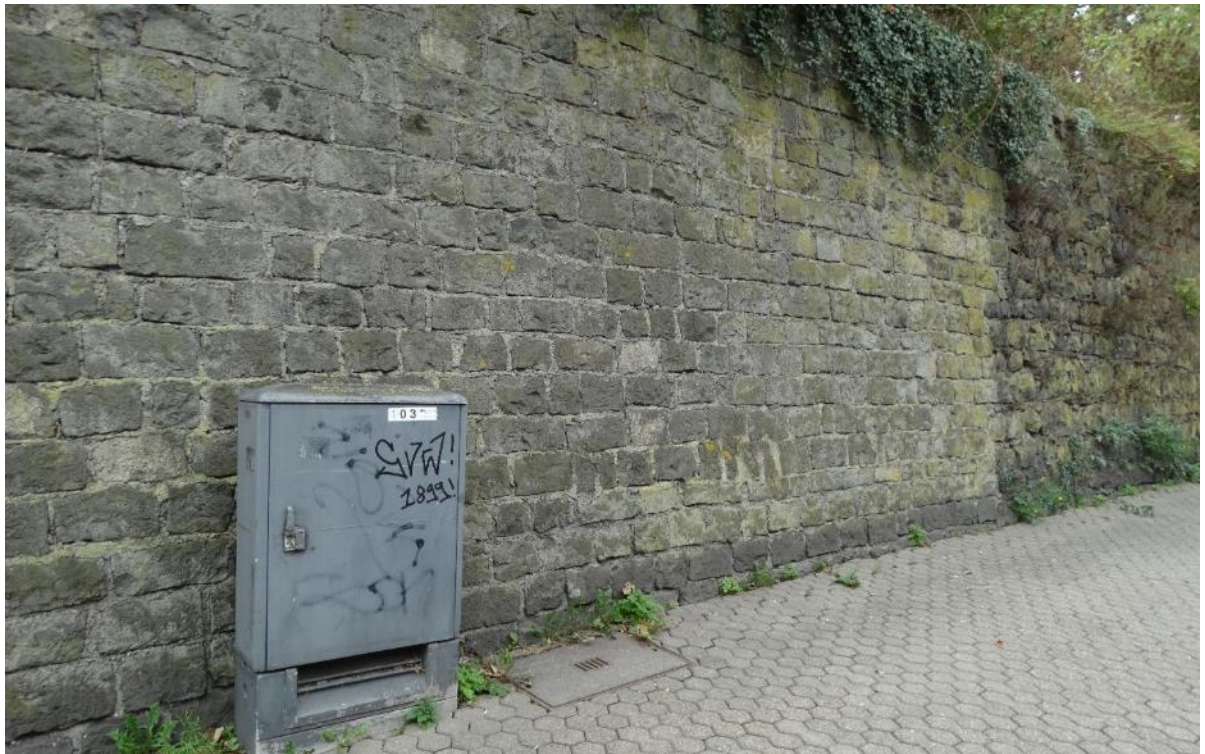
Wechsel zwischen hammerrechtem Schichtmauerwerk und Bruchsteinmauerwerk.
