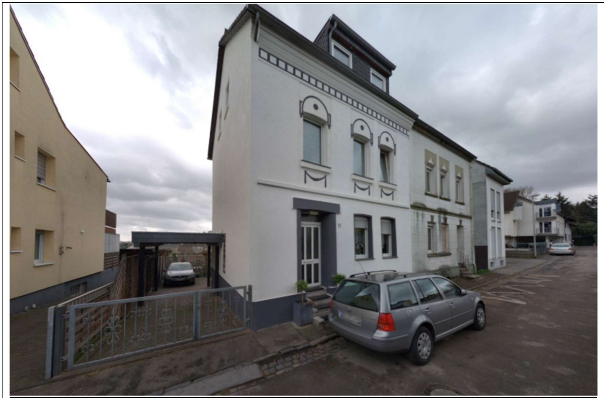
Abb. 2 – Wohnbebauung Leonhardstraße Nr. 11, 13 und 15
