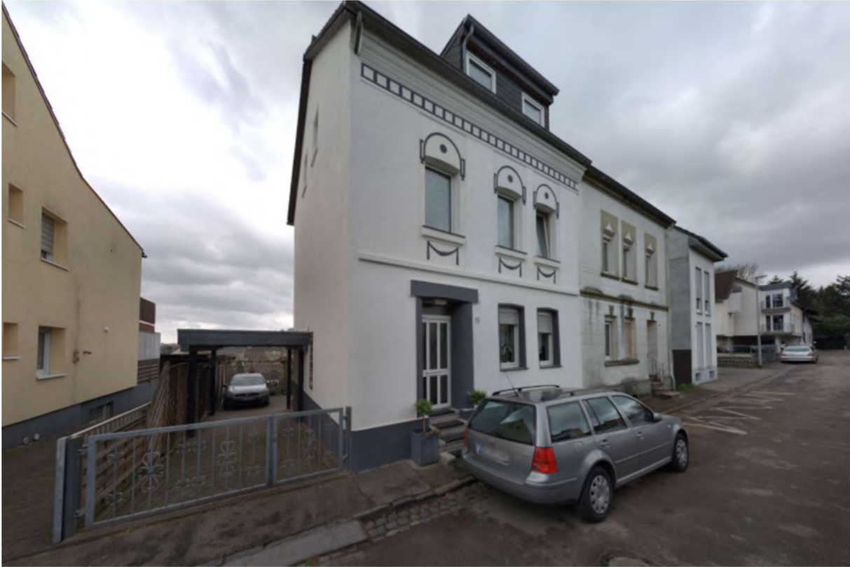
Abb. 2 – Wohnbebauung Leonhardstraße Nr. 11, 13 und 15
