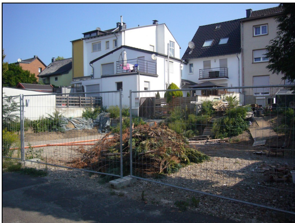
Abb. 5: Vorbereitetes Baugrundstück auf der östlichen Seite der Leonhardstraße.
