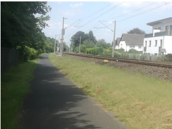
Foto 17: Geh-Radweg entlang der Bahn. Hier ist genügend Platz für eine Verbreiterung des Wegs auf 3 m.
