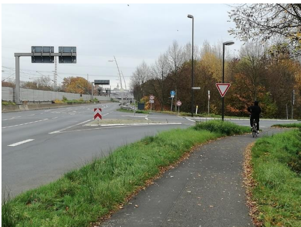
Foto 43: L332 Anschluss Uferstraße
