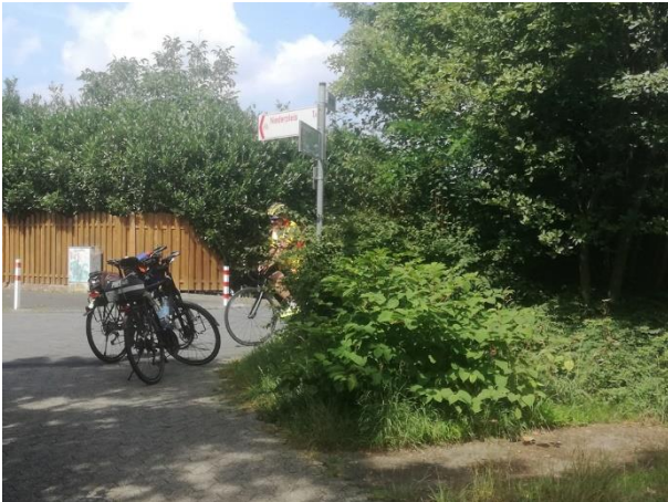
Foto 21: Zur Verbesserung der Sichtbeziehung sollte das Gebüsch rechts im Bereich der Einmündung von der Brücke in die Buisdorfer Straße entfernt werden.
