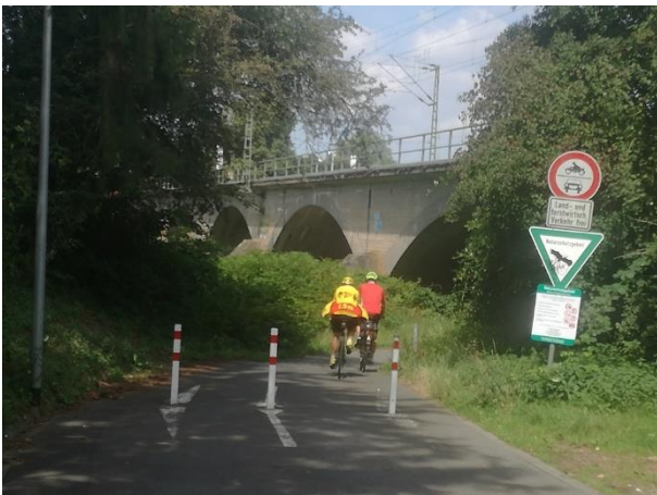
Foto 23: Am Ende der Uferstraße bietet es sich an, eine Geh-Radweg-Brücke entlang der Bahnbrücke zu bauen. Kurzfristig sind die Poller zu entfernen und die Sichtbeziehungen zu verbessern.
