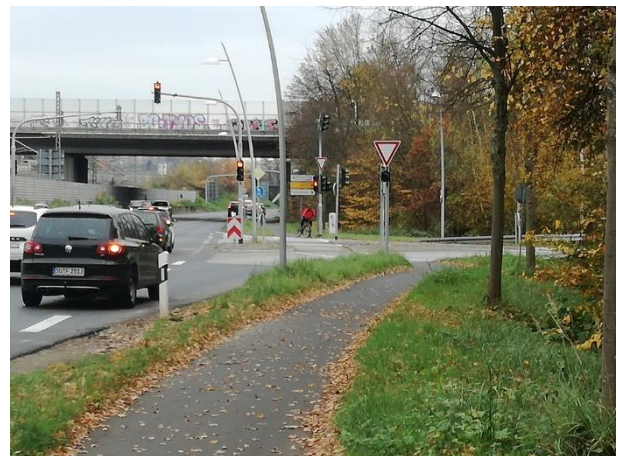
Foto 42: Anschlussstelle B56, Nordseite
