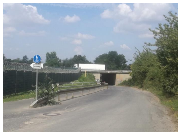
Foto 14: Unterführung unter der A3. Die Sichtbeziehung auf dem Geh-Radweg an der Unterführung ist schlecht, die Breite zu gering. Radfahrer sollten hier auf einer Fahrradstraße können, LKW-Fahrer im Bereich der Engstelle zu äußerster Vorsicht angehalten werden (Tempolimit).
