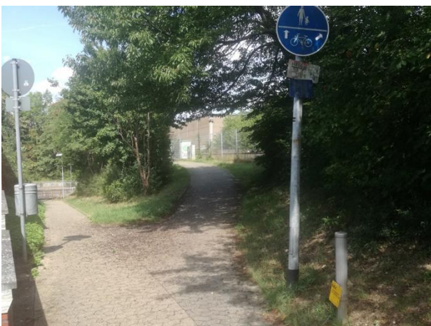
Foto 19: Zufahrt zur Brücke über die Hauptstraße. Die Zufahrt ist zu verbreitern; die Vorfahrtsregelung und Sichtbeziehung gegenüber dem von der Hauptstraße kommenden Weg zu optimieren.
