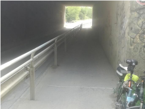
Foto 15: Unterführung unter der A3. Der Geh-Radweg im Gegenverkehr ist nur 2m breit und damit deutlich zu schmal. Beleuchtung ist erforderlich.
