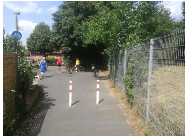
Foto 18: Ende des Geh-Radweg an Hochmeisterstraße. Die viel zu eng stehenden Poller sind zu entfernen.
