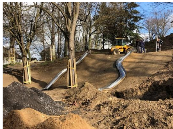
Abb. 13: Bau der Hangsicherung und des Spielplatzes Quelle: Atelier Esser
