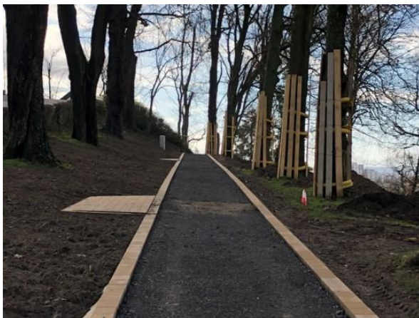
Abb. 12: Weg unterhalb des Rosengartens Quelle: Atelier Esser
