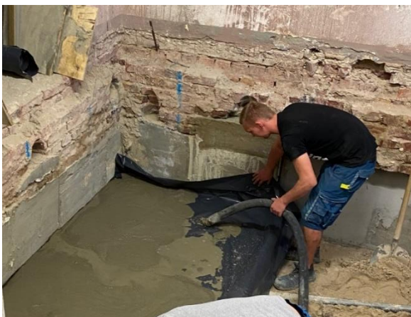
Abb. 16: Bauarbeiten Aufzug – VHS-Gebäude Quelle: Stadt Siegburg
