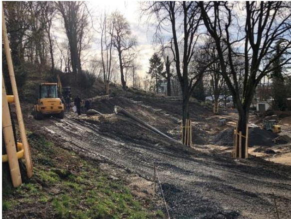
Abb. 14: Bau der Hangsicherung Quelle: Atelier Esser
