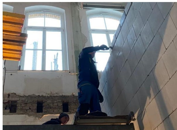
Abb. 17: Bauarbeiten Aufzug – VHS-Gebäude Quelle: Stadt Siegburg
