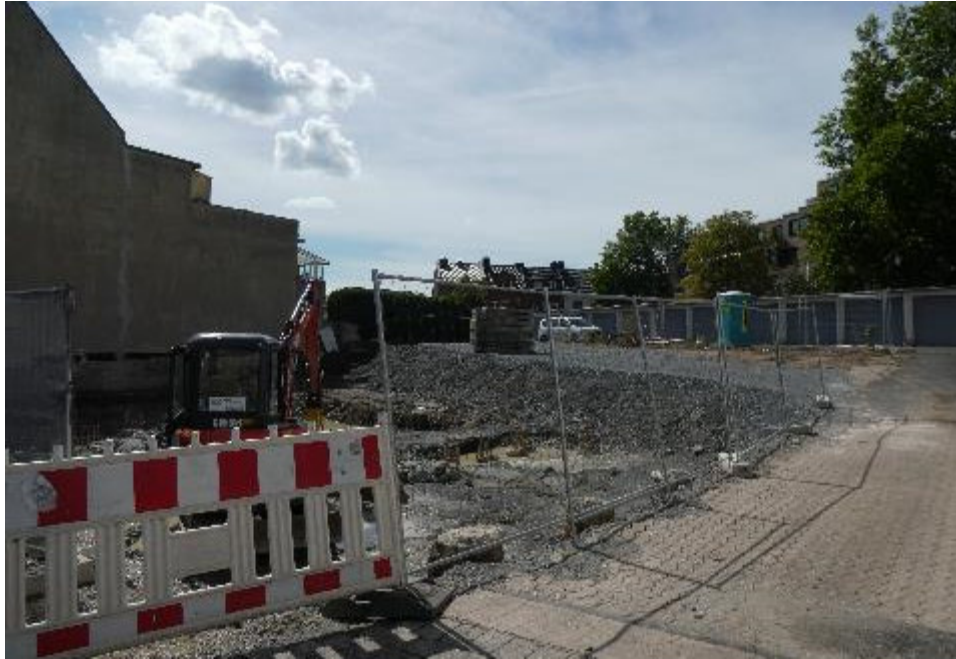
Abbildung 5: Baustelle im Bereich des Bebauungsplanes B39/3.
