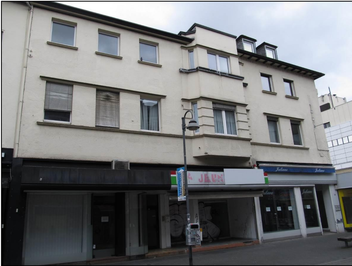
Abbildung 4: Straßenfront der Gebäude an der Kaiserstraße
