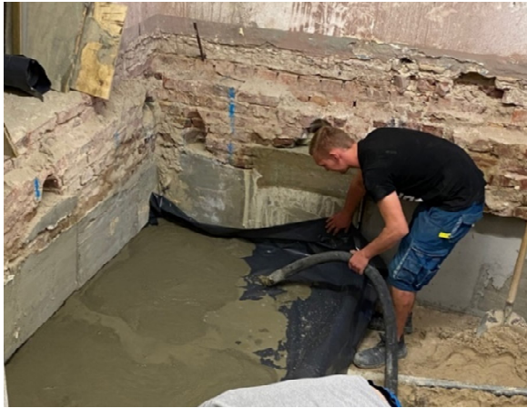
Abb.16: Bauarbeiten Aufzug – VHS-Gebäude Quelle: Stadt Siegburg
