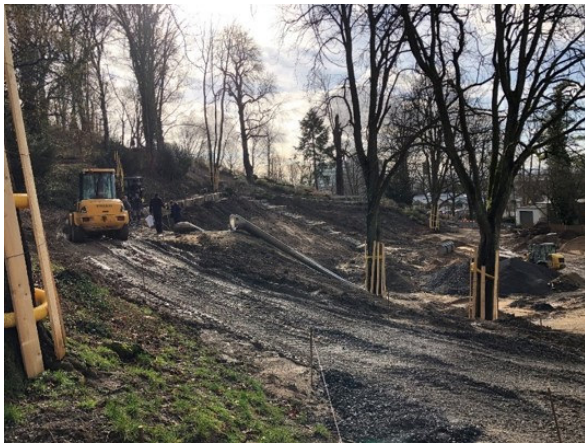
Abb.14: Bau der Hangsicherung Quelle: Atelier Esser
