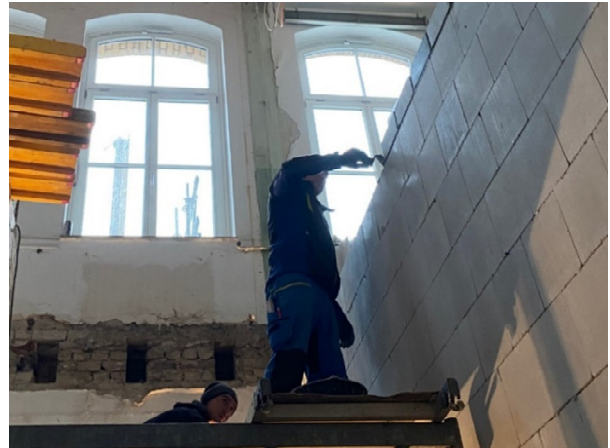
Abb. 17: Bauarbeiten Aufzug – VHS-Gebäude Quelle: Stadt Siegburg
