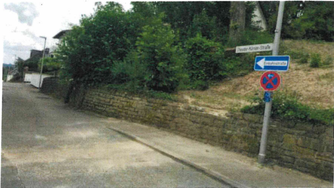
Hier ein Bild des „fließenden Sandbodens“ nach einem mittleren Regenfall am 20.06.21 aus der Theodor-Körner-Str., Höhe Nr. 14.
