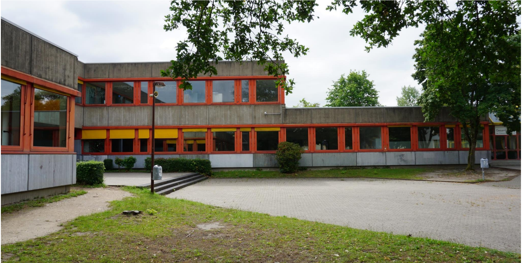
Foto: Bestandsfassade Teilansicht Nord
