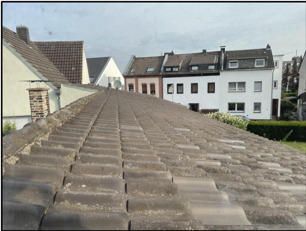
Abb. 3: Dach aus Tonziegeln, Wahnbachtalstraße 4, Siegburg
