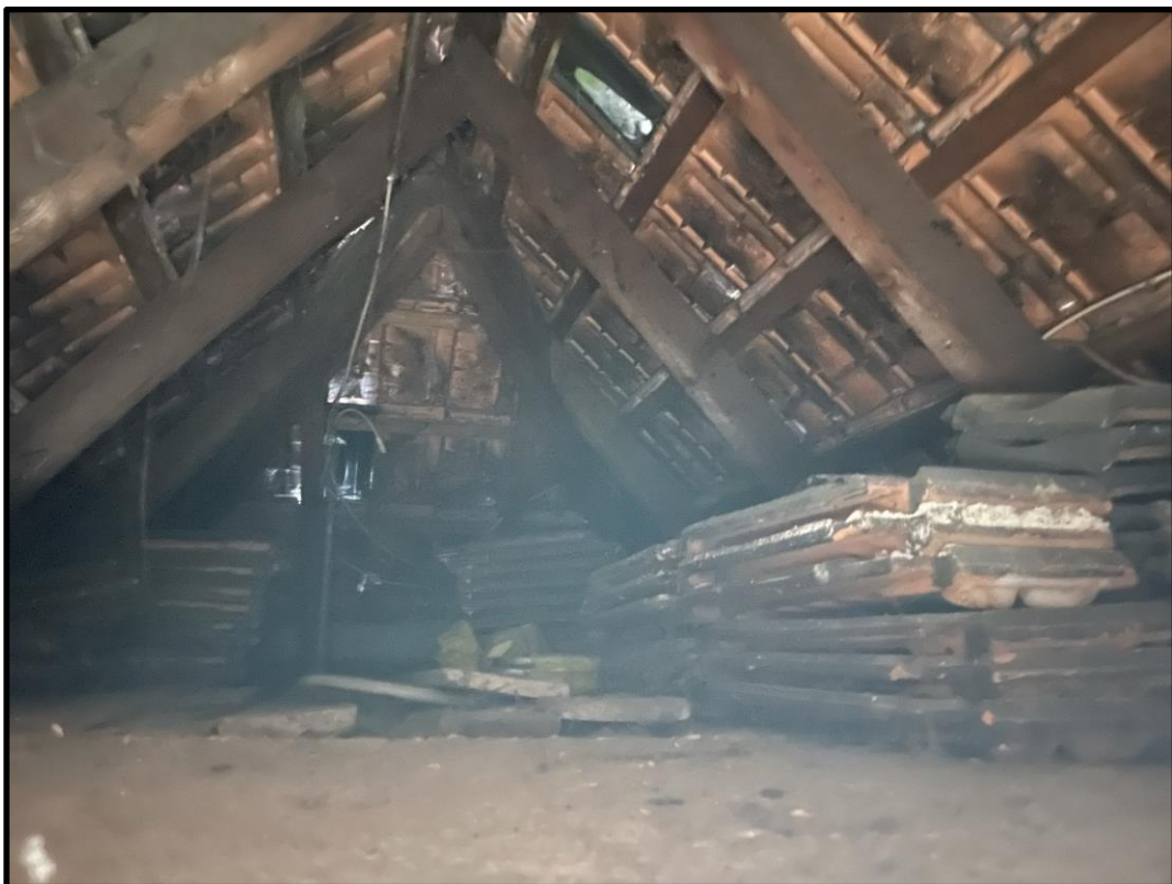
Abb. 2: ungedämmter Dachstuhl, Wahnbachtalstraße 4, Siegburg
