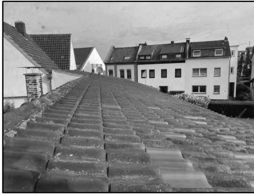
Abb. 3: Dach aus Tonziegeln, Wahnbachtalstraße 4, Siegburg
