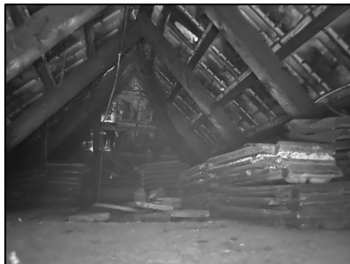
Abb. 2: ungedämmter Dachstuhl, Wahnbachtalstraße 4, Siegburg
