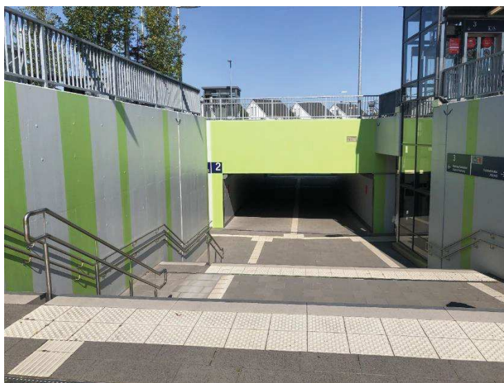
Abbildung 16: Helle und übersichtlich gestaltete Unterführung am Bahnhof Meckenheim
