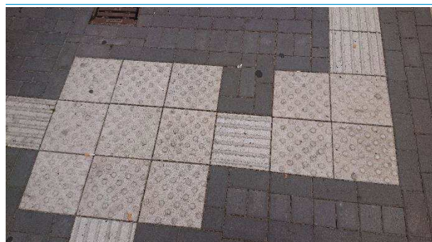
Abbildung 10: Rippenpflaster als Auffinde-/Leitstreifen und Noppenpflaster als Einstiegs- und Aufmerksamkeitsfelder
