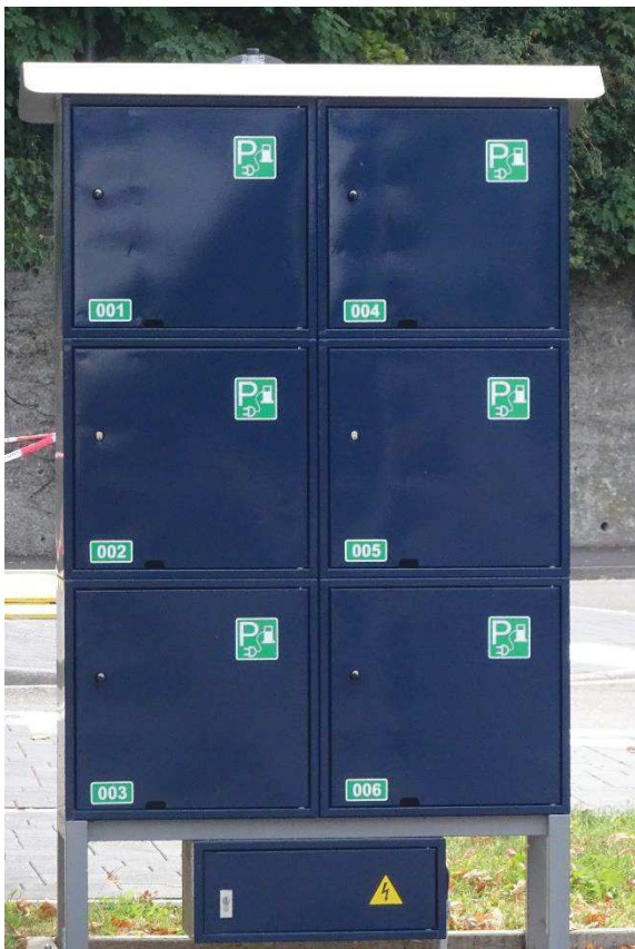
Abbildung 25: Beispiel Schließfach mit integrierter Lademöglichkeit in Lahr
