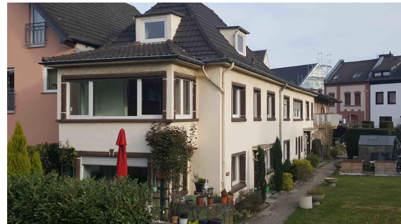
Plangebiet, Hausgruppe mit östlich angrenzendem Garten – Blick aus Richtung Wahnbachtalstraße
