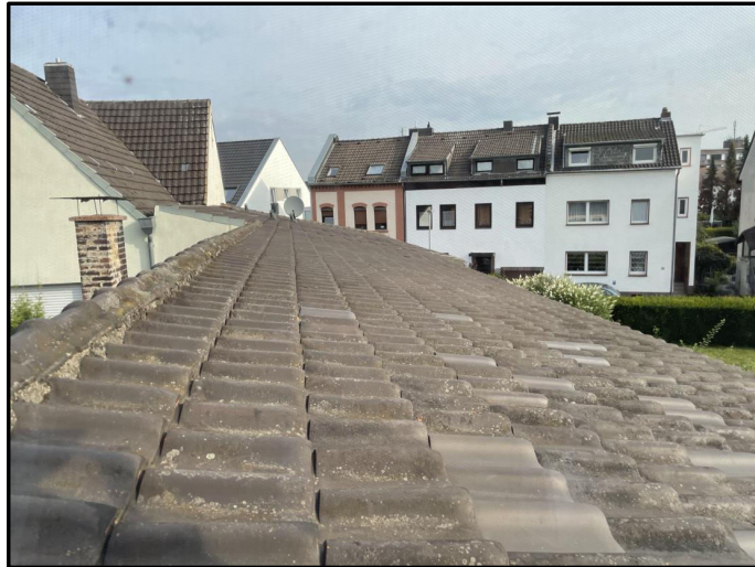
Abb. 3: Dach aus Tonziegeln, Wahnbachtalstraße 4, Siegburg
