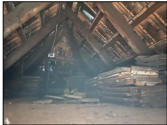
Abb. 2: ungedämmter Dachstuhl, Wahnbachtalstraße 4, Siegburg
