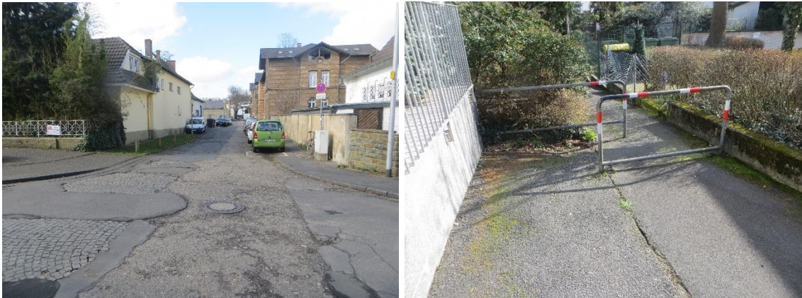
Abbildung 13: Mängel für Gehbehinderte Menschen im Untersuchungsgebiet, beispielsweise fehlende Absenkungen und zu enge Umlaufsperrn
