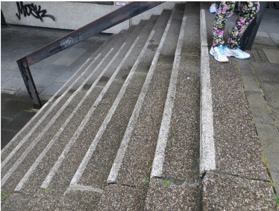
Abbildung 31: Teilweise verblasste Markierung der Stufen am Rathaus
