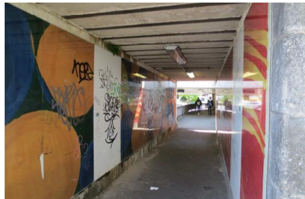
Abbildung 6: Unterführung Mahrstraße Quelle: Stadt Siegburg
