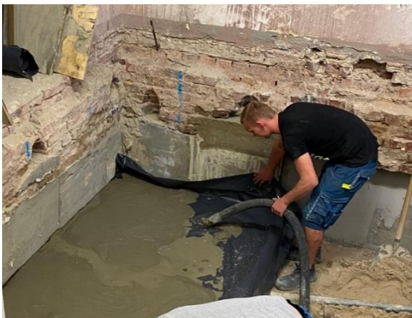
Abbildung 21: Bauarbeiten Aufzug - VHS-Gebäude Quelle: Stadt Siegburg
