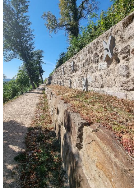
Abbildung 18: Sanierte Mauer Quelle: DSK
