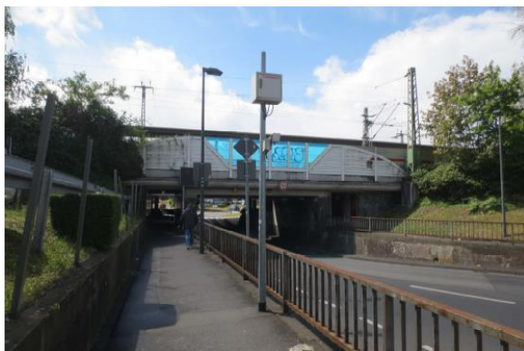
Abbildung 5: Unterführung Mahrstraße Quelle: Stadt Siegburg
