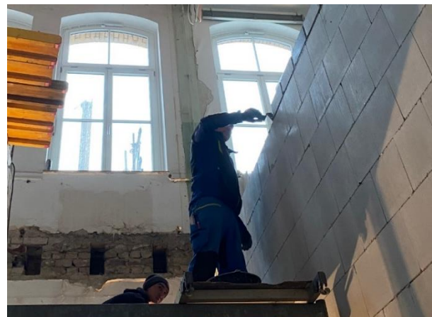
Abbildung 22: Bauarbeiten Aufzug - VHS-Gebäude Quelle: Stadt Siegburg
