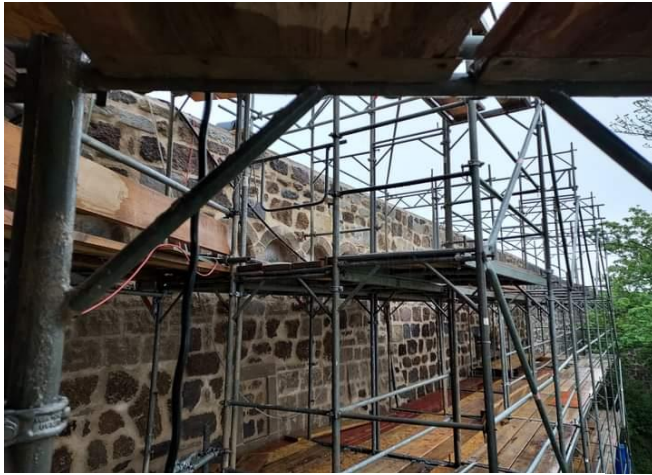
Abbildung 17: Mauersanierung Quelle: Stadt Siegburg
