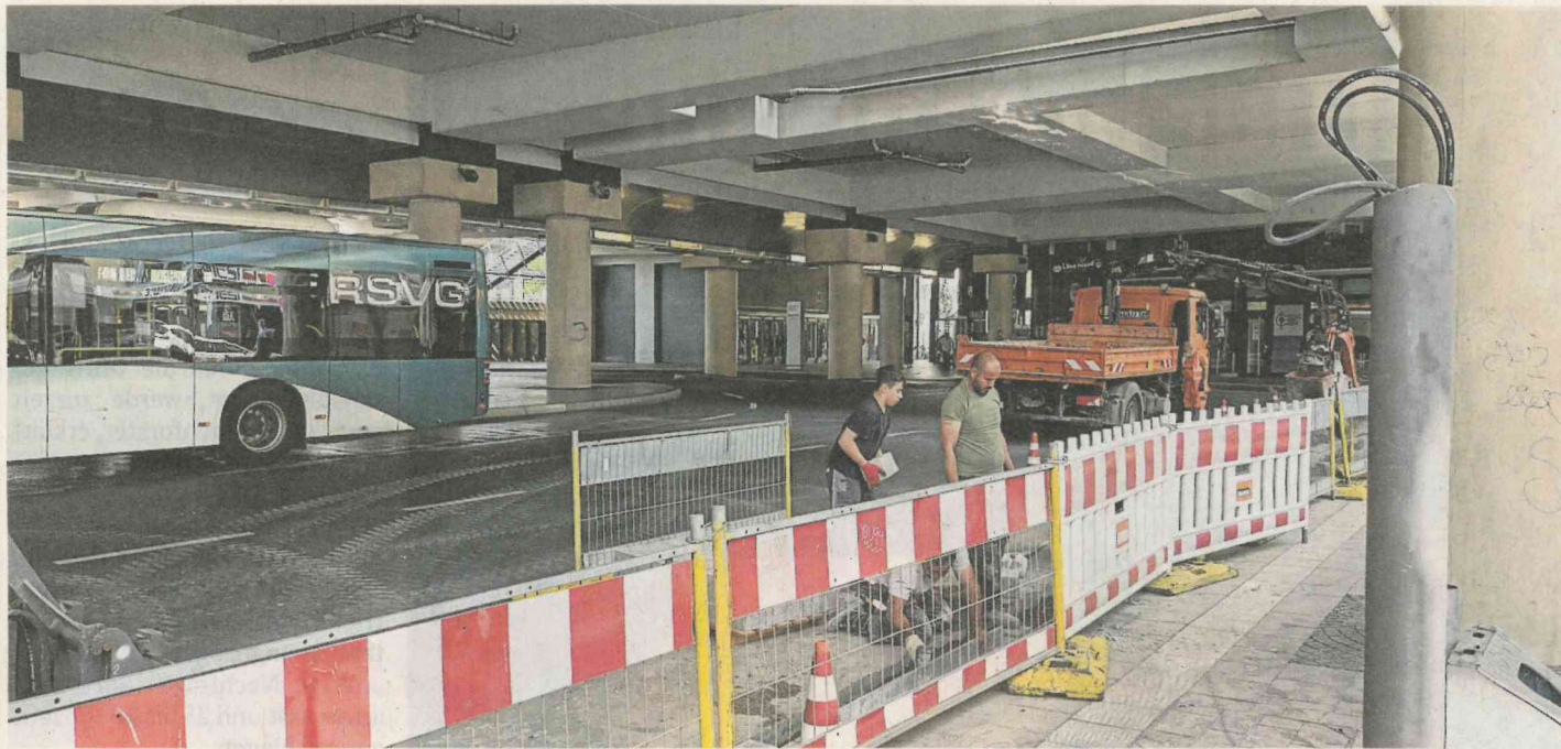
Am Busbahnhof in Siegburg laufen Bauarbeiten für das moderne Informationssystem.
