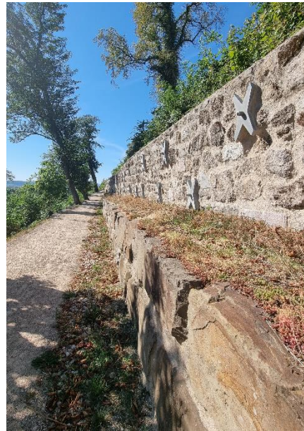
Abbildung 18: Sanierte Mauer Quelle: DSK
