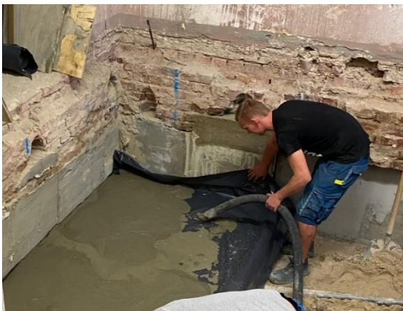
Abbildung 21: Bauarbeiten Aufzug - VHS-Gebäude Quelle: Stadt Siegburg
