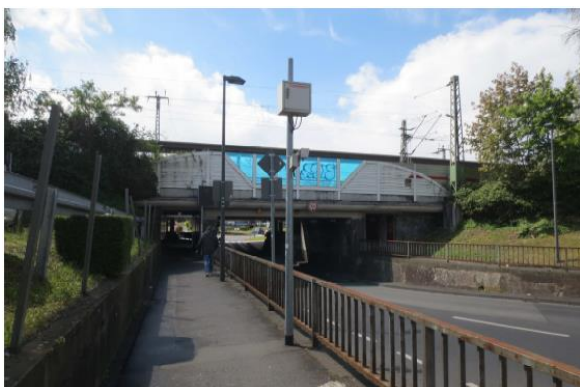
Abbildung 5: Unterführung Mahrstraße Quelle: Stadt Siegburg
