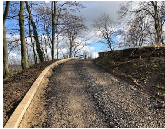
Abbildung 16: Sichtbarmachung der ehemaligen Bastion Quelle: Atelier Esser
