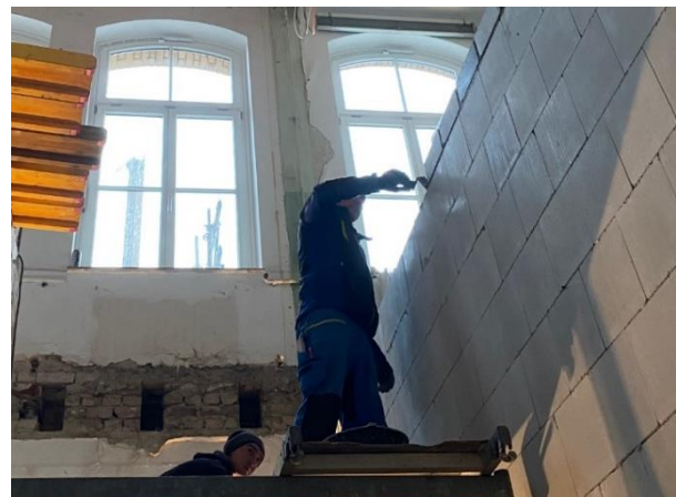
Abbildung 22: Bauarbeiten Aufzug - VHS-Gebäude Quelle: Stadt Siegburg
