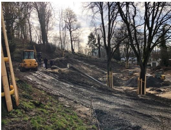
Abbildung 15: Bau der Hangsicherung Quelle: Atelier Esser
