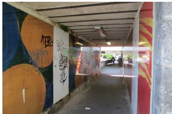
Abbildung 6: Unterführung Mahrstraße Quelle: Stadt Siegburg
