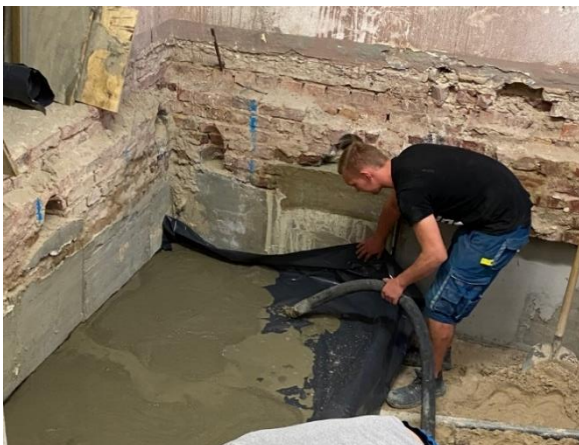
Abbildung 23: Bauarbeiten Aufzug - VHS-Gebäude Quelle: Stadt Siegburg
