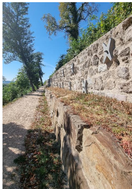
Abbildung 20: Sanierte Mauer Quelle: DSK
