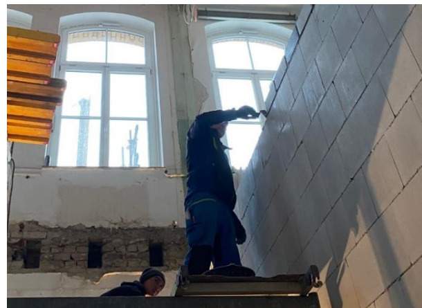
Abbildung 24: Bauarbeiten Aufzug - VHS-Gebäude Quelle: Stadt Siegburg
