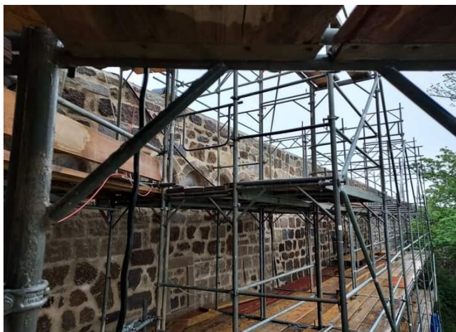
Abbildung 19: Mauersanierung Quelle: Stadt Siegburg
