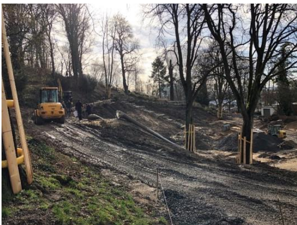
Abbildung 17: Bau der Hangsicherung Quelle: Atelier Esser
