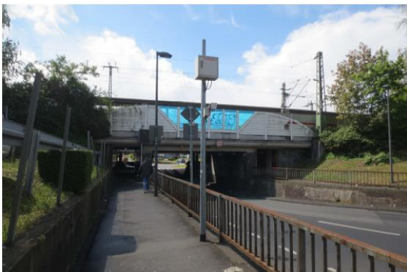
Abbildung 5: Unterführung Mahrstraße Quelle: Stadt Siegburg
