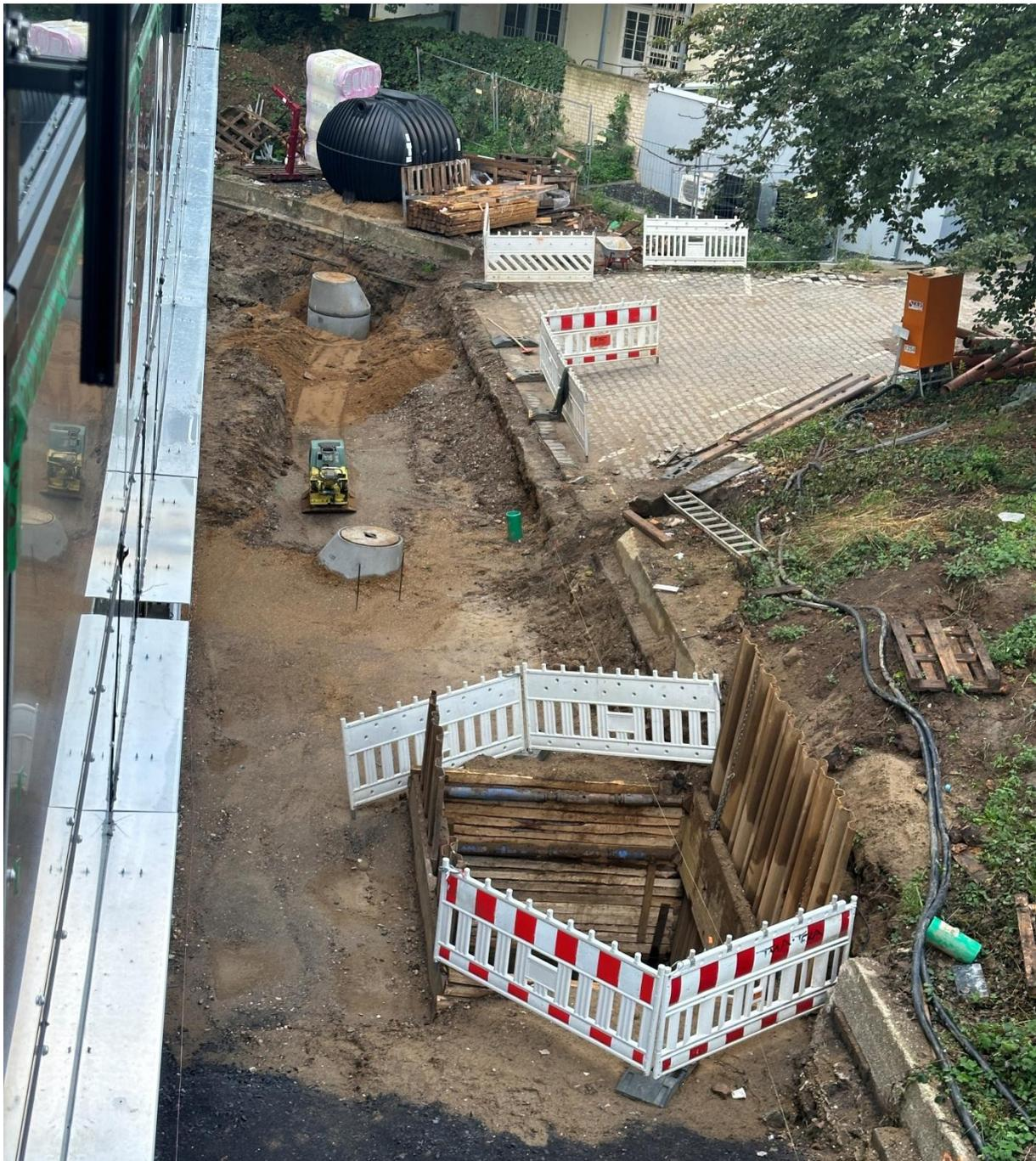
Des Weiteren wurde bei den Arbeiten vor dem Ratstrakt festgestellt, dass sich ab einer Tiefe von ca. 2,50 Metern aufgestautes Oberflächenwasser befindet, sog. Schichtenwasser, welches aufgrund einer wasserstauenden Bodenschicht nicht versickern kann. Das Schichtenwasser kann nicht abgepumpt werden und flutet die Baugrube, in die die Zisterne eingebracht werden soll:
