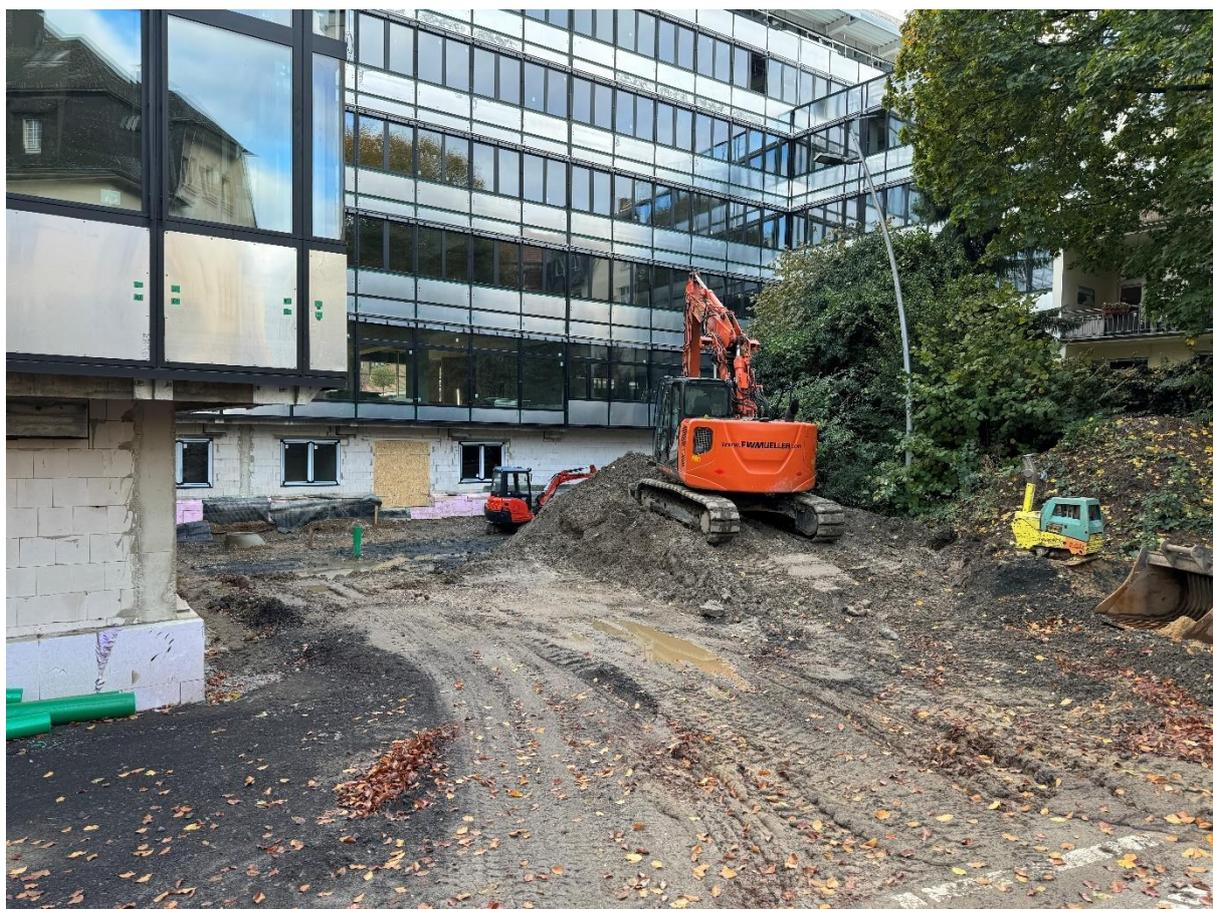
Aufgrund des vor dem Ratstrakt vorgefundenen Oberflächenwassers hat eine erneute gutachterliche Untersuchung der Baugrund- und Grundwassersituation stattgefunden. Das aufgestaute Oberflächenwasser ist aller Voraussicht nach im gesamten Tiefhof zu erwarten, es ist zudem nicht auszuschließen, dass es sich hierbei bereits um Grundwasser handelt.
