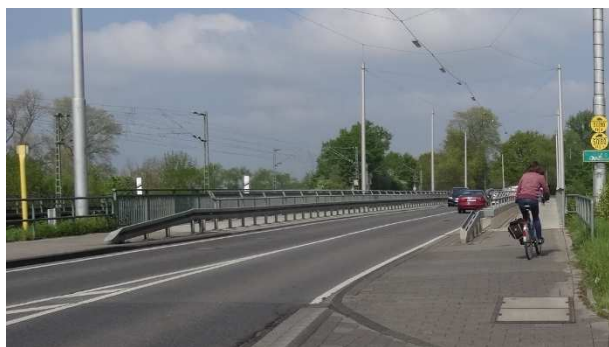
Bild 58: Brücke Frankfurter Straße – beidseitig gemeinsamer Geh-/Radweg
