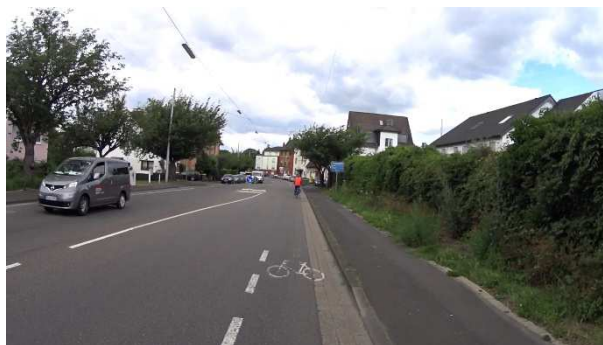
Bild 65: Frankfurter Straße – Unterbrechung Schutzstreifen im Zuge einer Querungsanlage
