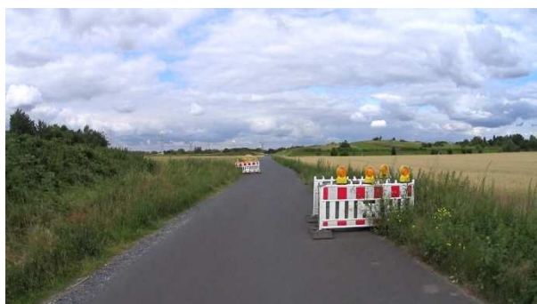
Bild 40: Betonhindernisse – hier mit Sicherheitsbarken umzäunt
