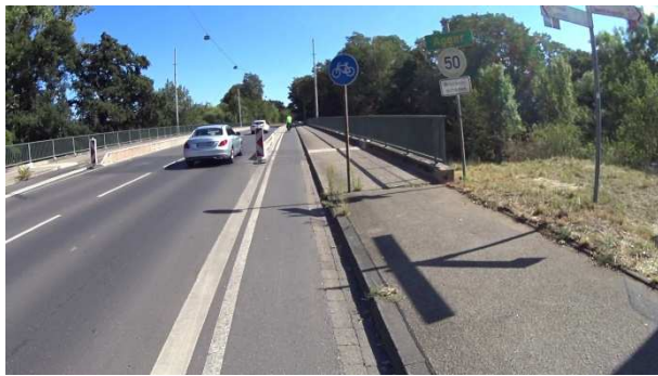
Bild 154: Aggerquerung – baulich getrennter Radweg
