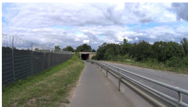
Bild 3: Östliche Zufahrt zur Unterführung A 3 – Schutzeinrichtung als bauliche Trennung zur Fahrbahn
