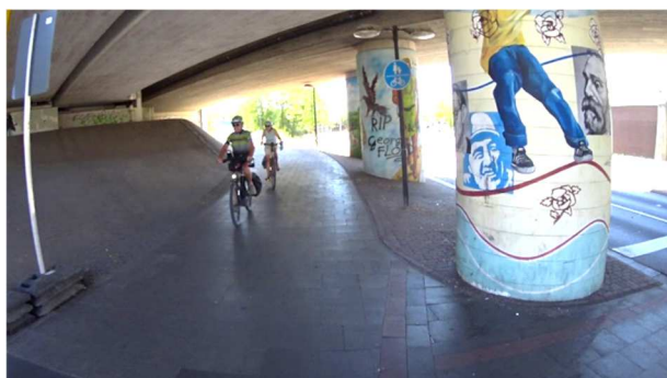
Bild 102: Bahnstreckenunterführung – gemeinsamer Geh- und Radweg im Zweirichtungsbetrieb (von Westen kommend)
