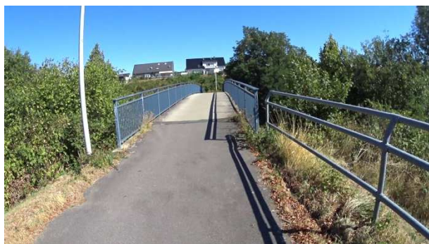
Bild 124: Brückenanlage L 332 – gemeinsamer Geh- und Radweg im Zweirichtungsbetrieb
