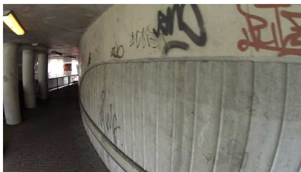
Bild 75: Bahnunterführung – Seitenraum östliche Straßenseite in Richtung Mahrstraße
