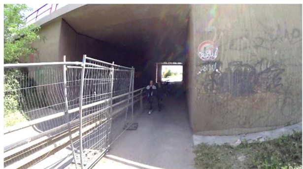
Bild 49: Unterführung A 3 – Durchfahrt aus westlicher Richtung kommend (Bauzaun ist temporär abgestellt)
