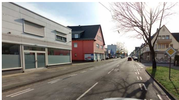
Bild 158: Luisenstraße (L 333) – beidseitige Schutzstreifenmarkierung [Bildquelle: Street Smart]
