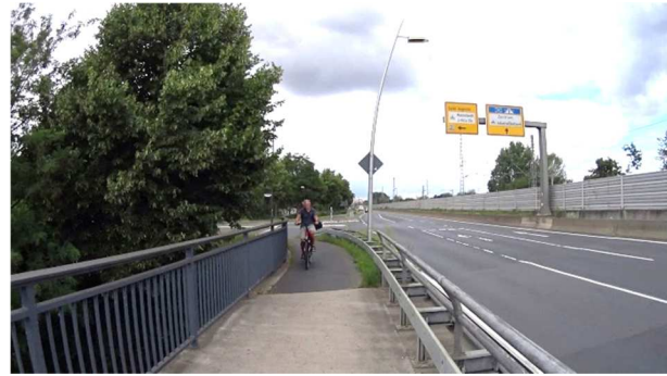
Bild 98: L 332 – Querung L 143 (Uferstraße)
