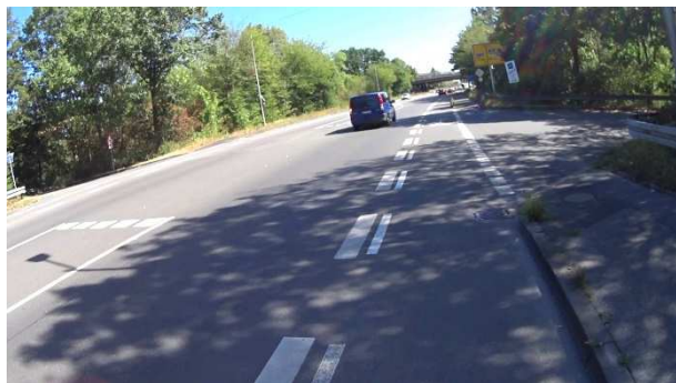
Bild 156: Knotenpunkt Luisenstraße (L 333)/An der Aggerbrücke – fehlende Querungshilfe
