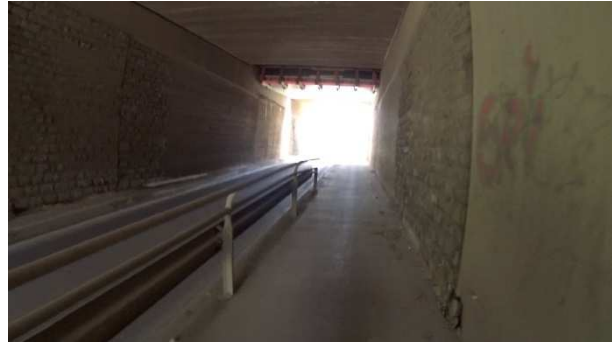
Bild 51: Unterführung A 3 – Durchfahrt aus westlicher Richtung kommend
