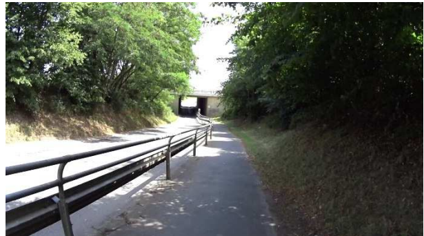
Bild 47: Westliche Zufahrt zur Unterführung A 3 – Schutzeinrichtung als bauliche Trennung zur Fahrbahn
