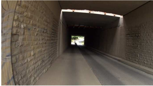
Bild 50: Unterführung A 3 – Durchfahrt aus östlicher Richtung kommend
