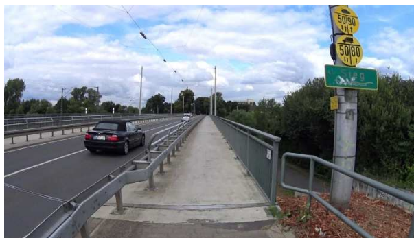
Bild 59: Brücke Frankfurter Straße – Schutzeinrichtung
