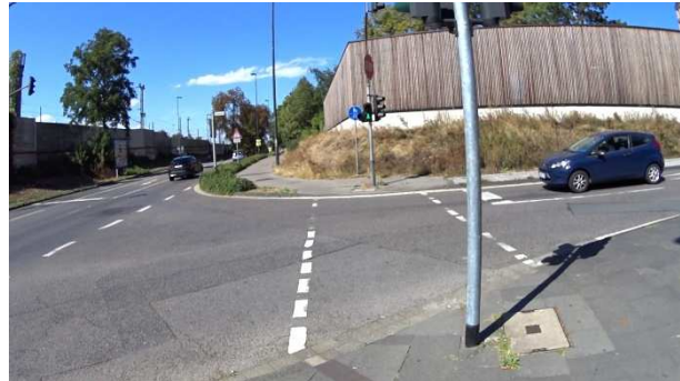
Bild 105: Knotenpunkt Theodor-Heuss-Ring (B 8)/Steinhof – gemeinsamer Geh- und Radweg
