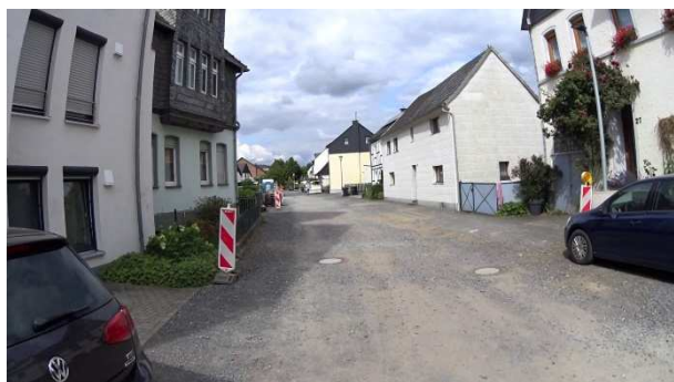
Bild 34: Geistinger Straße zwischen Bergstraße und Hans-Weber-Straße (Baustellenbereich)
