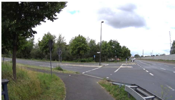
Bild 99: Knotenpunkt L 332 (Willy-Brandt-Ring)/L 143 (Uferstraße)
