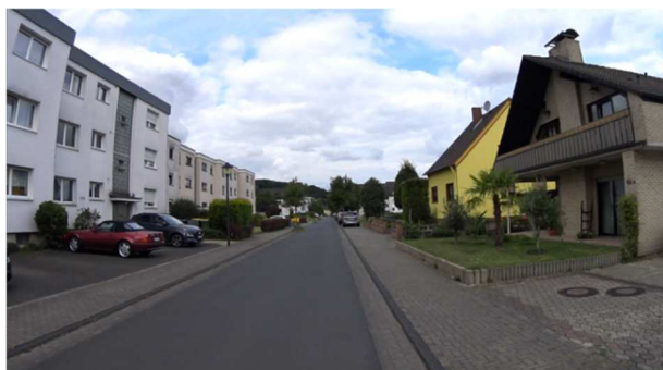
Bild 28: Kurhausstraße – Gestaltung nach dem Trennungsprinzip
