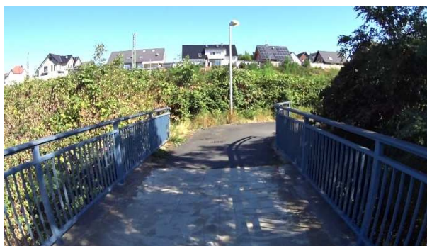
Bild 125: 90-Grad-Kurve im Anschluss an die Brückenanlage L 332
