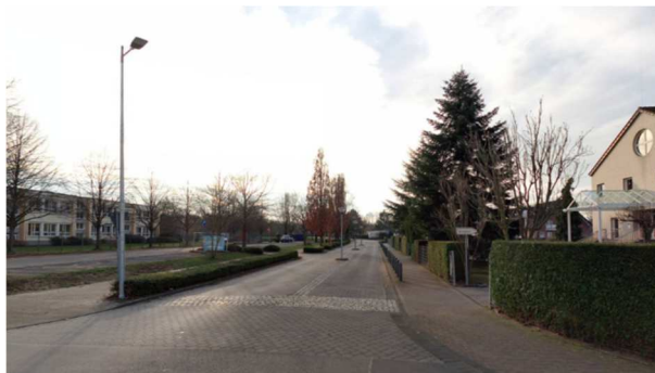
Bild 139: Aggerdamm (zwischen Matthias-Langen-Straße und Kreisverkehrsplatz) – Mischverkehrsführung [Bildquelle: Stadt Troisdorf]
