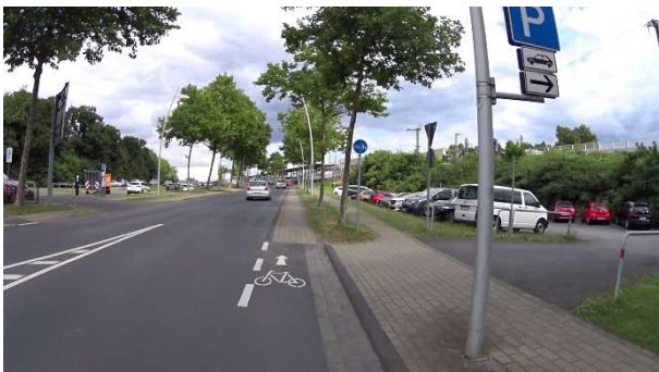
Bild 81: Konrad-Adenauer-Allee – Beginn getrennter Geh- und Radweg (nördliche Straßenseite)
