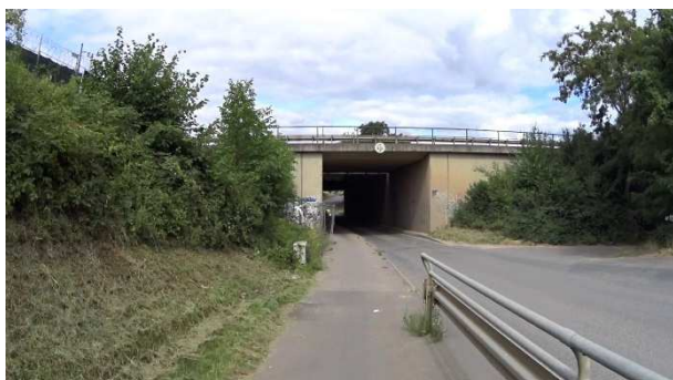
Bild 48: Östliche Zufahrt zur Unterführung A 3 – Ende Schutzeinrichtung (bauliche Trennung zur Fahrbahn mit Hochbord)
