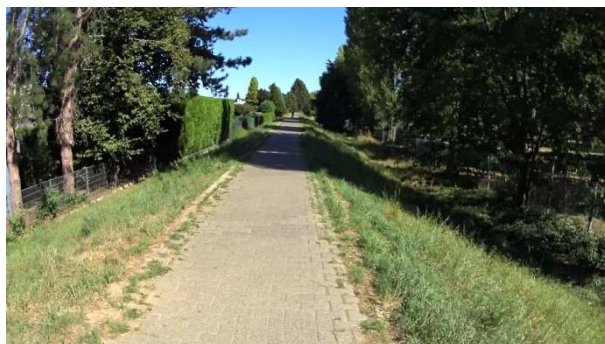
Bild 144: Aggerdamm – zwischen Schwimmbad und Frankfurter Straße (B 8)
