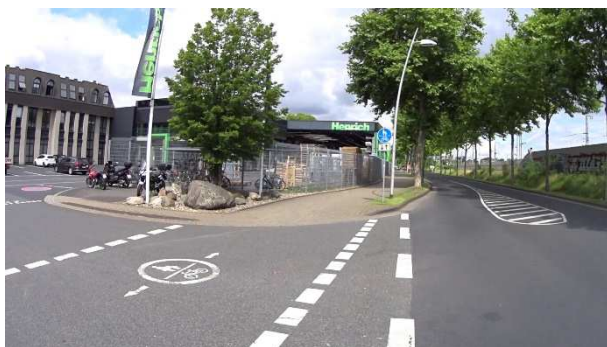
Bild 86: Konrad-Adenauer-Allee – Grundstückszufahrt Baustoffzentrum
