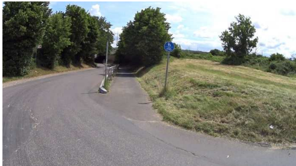
Bild 46: Westliche Zufahrt zur Unterführung A 3 – Beginn gemeinsamer Geh-/Radweg (Zweirichtungsbetrieb)
