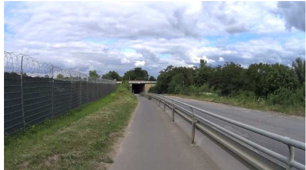
Bild 45: Östliche Zufahrt zur Unterführung A 3 – Schutzeinrichtung als bauliche Trennung zur Fahrbahn
