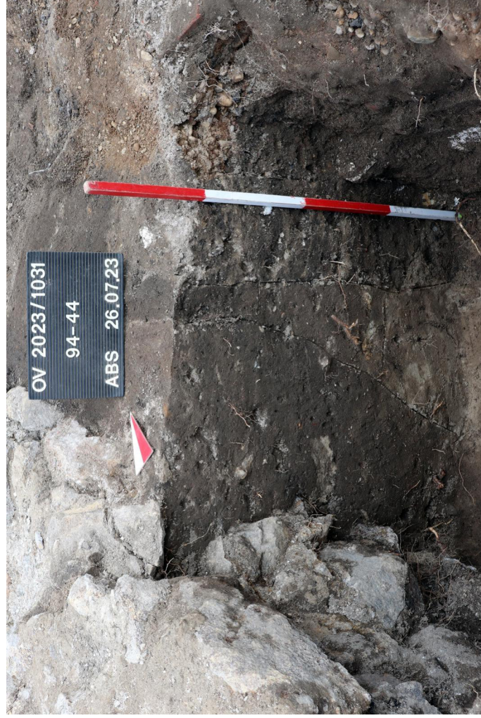
Abb. 23 Siegburg, Burggasse – Orestiastr. – Guardastr. (OV 2023/1031). Fundament des Gebäudes St. 94 im Osten mit Baugrube.
