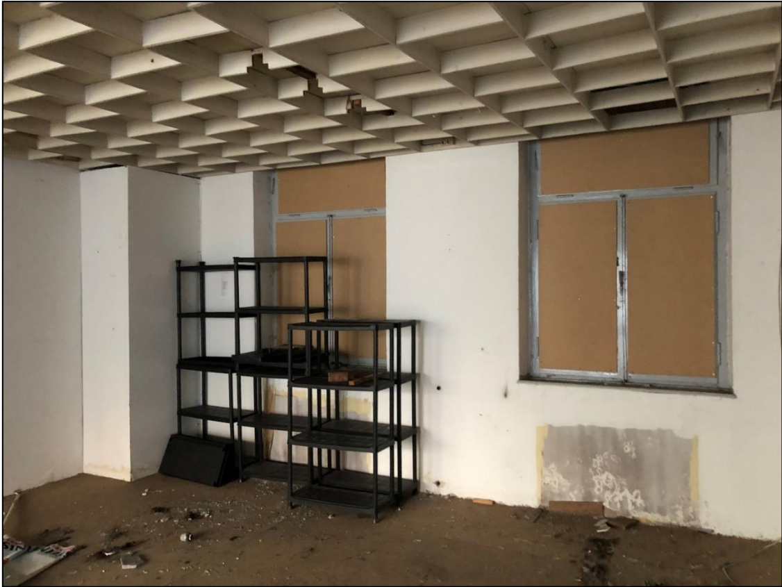
Abbildung 7: Beispiel 1 für einen Innenraum mit verschlossenen Fenstern
