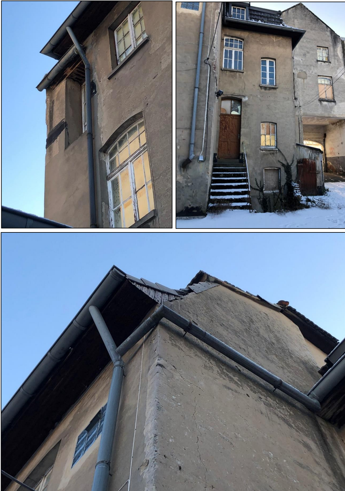
Abbildung 3: Rückseitige Gebäudeansicht mit Außenfassade und Dachüberstand
