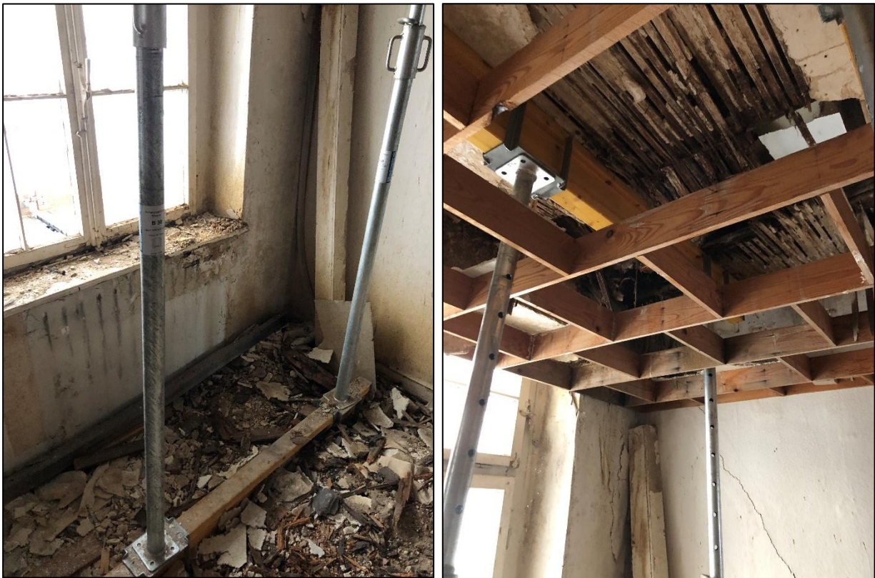
Abbildung 6: Fußböden, Wände (links) und Decke (rechts) in einem Richtung Nordwest gerichteten Innenraum
