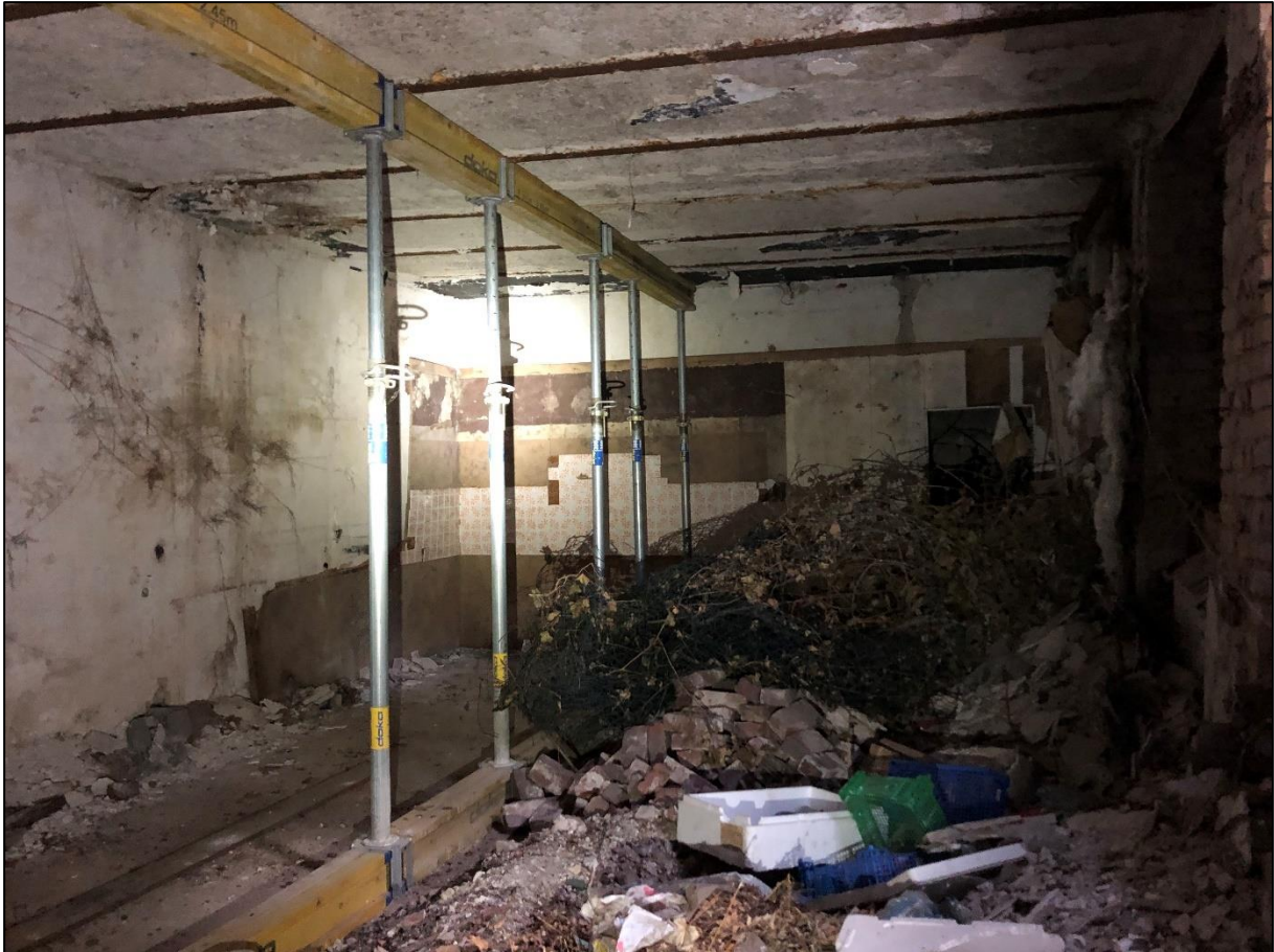
Abbildung 17: Innenbereich des Backsteingebäudes mit Stahlträgern
