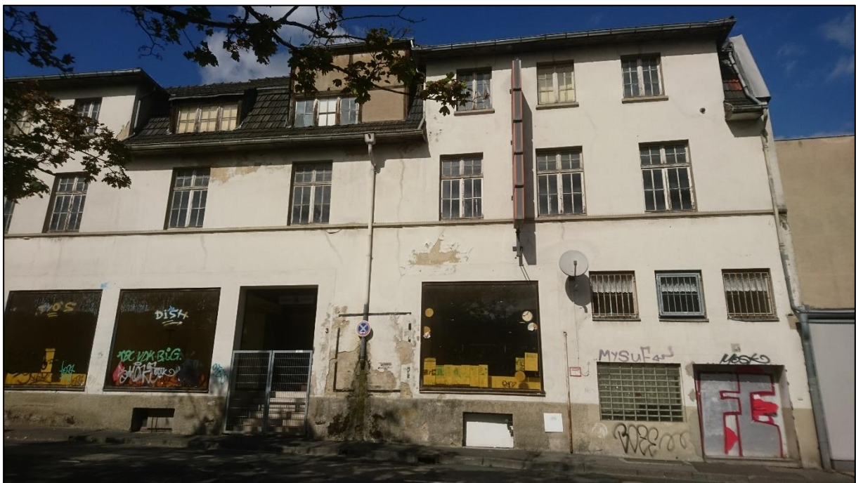
Abbildung 2: Frontalansicht des Gebäudes im Jahr 2019
