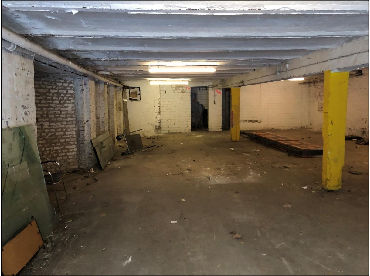
Abbildung 12: Zentraler Kellerraum durch Rolltor zugänglich
