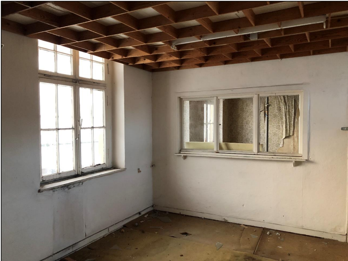
Abbildung 8: Beispiel 2 für einen Innenraum mit verschlossenen Fenstern
