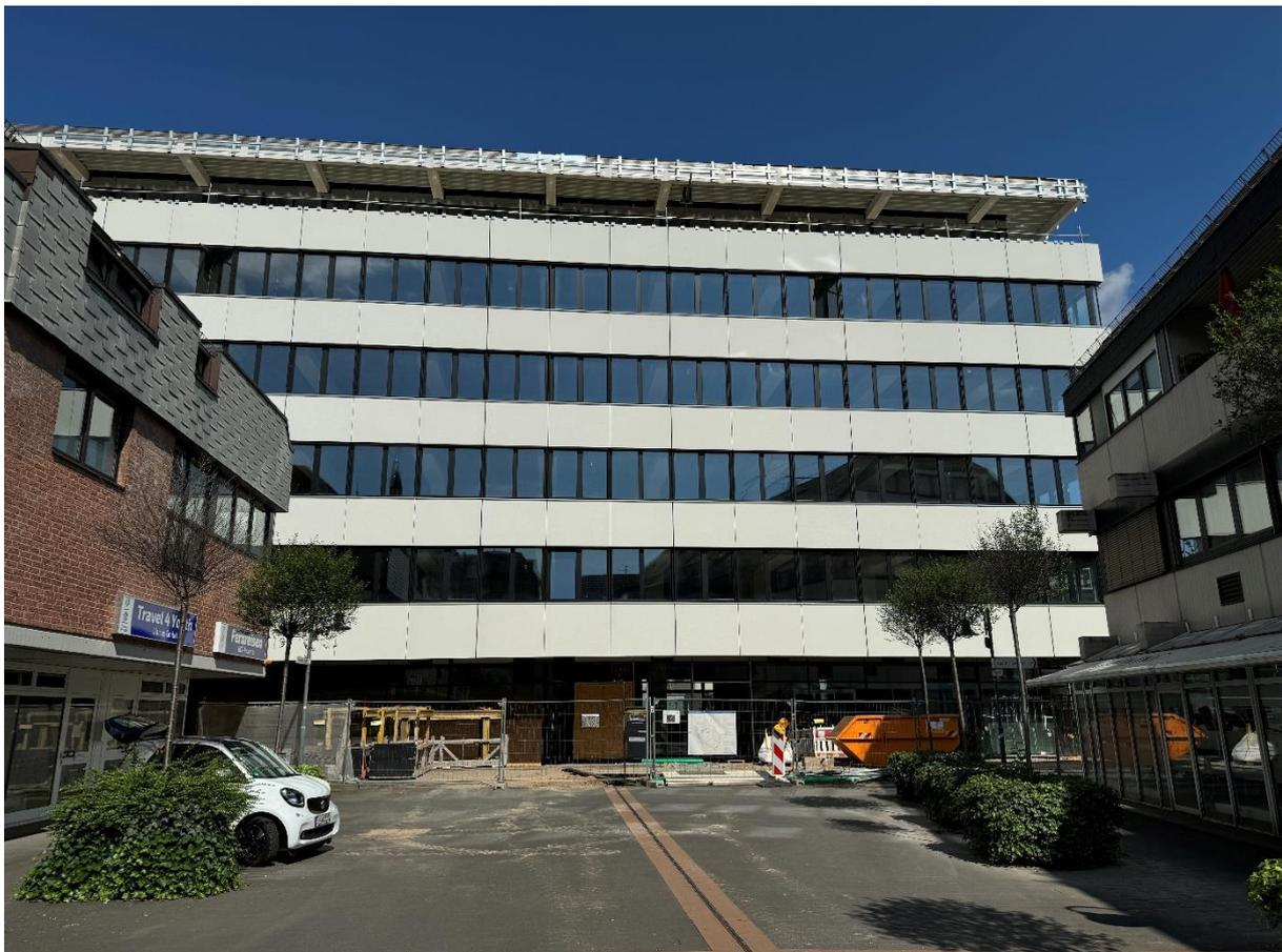
Die Anbringung der obersten Plattenreihe im neuen Dachgeschoss erfolgt voraussichtlich Ende Juni mit Hilfe eines Krans, der vor dem Haupteingang aufgebaut wird. Die unterste Reihe wird zum Schutz der Textilbetonplatten erst zu einem späteren Zeitpunkt montiert.
