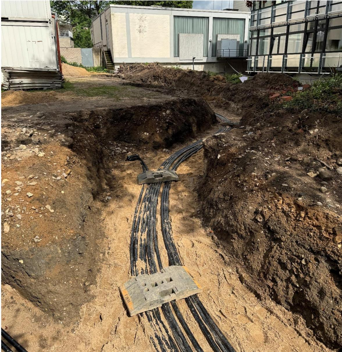
Die Sonden- und Verbindungsleitungen wurden gespült und mit Wasser abgedrückt. Die Befüllung mit Glykol erfolgt erst mit der Inbetriebnahme der Anlage, die gemeinsam mit der Inbetriebnahme der Wärmepumpen vorgesehen ist.
