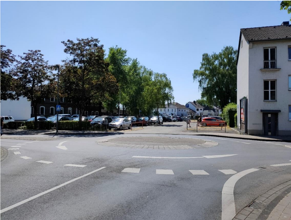
Abbildung 11: Kreisverkehr am Knotenpunkt Wilhelmstraße/Zum Rhein Sieg Forum (Quelle: IVV eigene Aufnahme)
