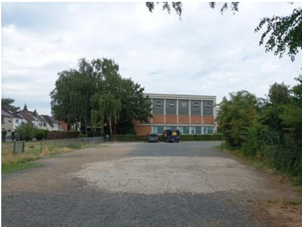
Abbildung 6: Blick aus Osten über den Schotterparkplatz auf die Sporthalle der ehemaligen Hauptschule. Potenzielle Lebensstätten für Vögel befinden sich im Bereich der Bäume sowie Hecken sowie an der Fassadenbegrünung (Efeu) der Sporthalle. Im Bereich der Attika sind Lebensstätten für Fledermäuse möglich.
