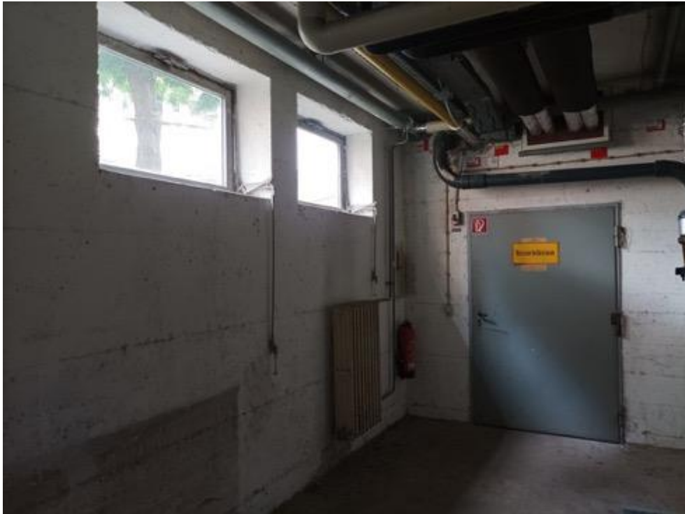
Abbildung 11: Kellergeschoss im Schulgebäude. Ein Zugang von Tierarten ist von außen nicht möglich.
