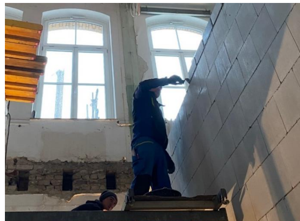
Abbildung 25: Bauarbeiten Aufzug - VHS-Gebäude Quelle: Stadt Siegburg
