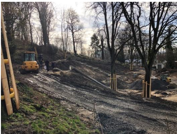
Abbildung 17: Bau der Hangsicherung Quelle: Atelier Esser
