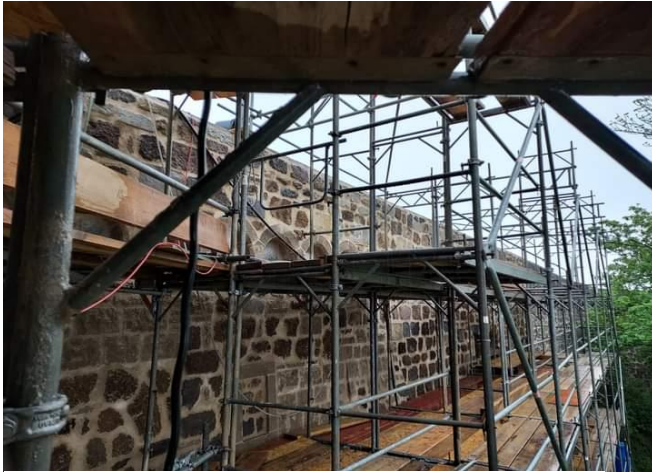
Abbildung 19: Mauersanierung Quelle: Stadt Siegburg
