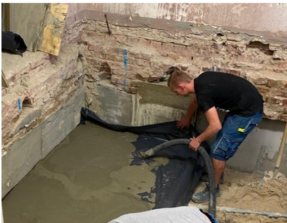
Abbildung 24: Bauarbeiten Aufzug - VHS-Gebäude Quelle: Stadt Siegburg
