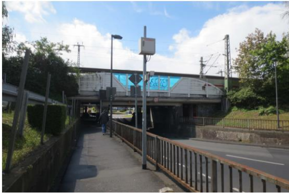
Abbildung 5: Unterführung Mahrstraße Quelle: Stadt Siegburg
