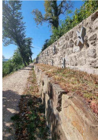
Abbildung 20: Sanierte Mauer Quelle: DSK
