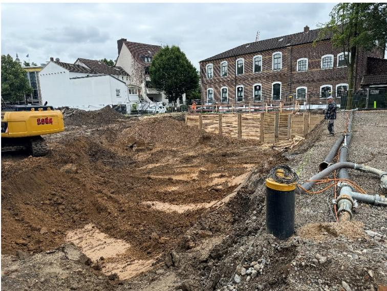
Vorbereitung Baugrube und Inbetriebnahme der Wasserhaltung
