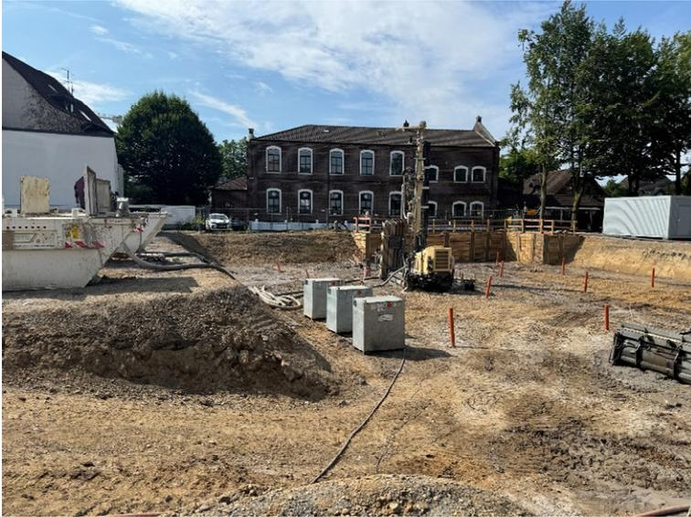
Bohrung der Geothermiesonden
