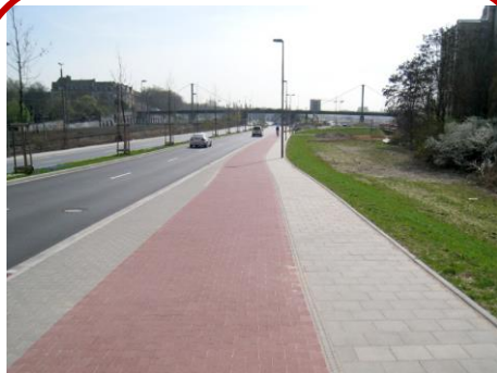
Baulich angelegter Radweg Einrichtungsverkehr
