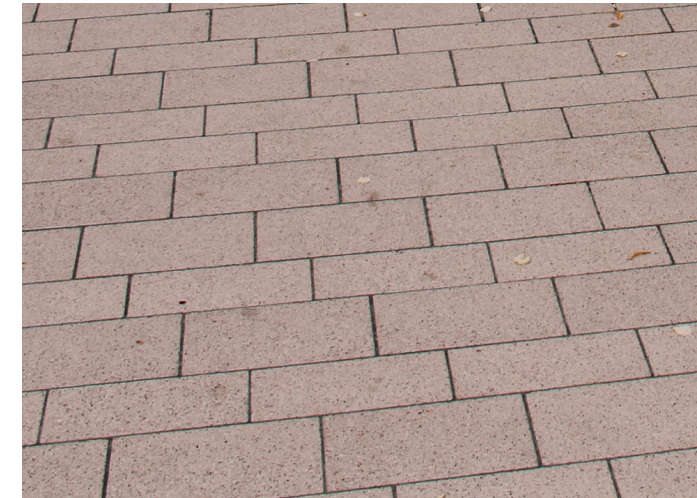
Betonsteinpflaster
