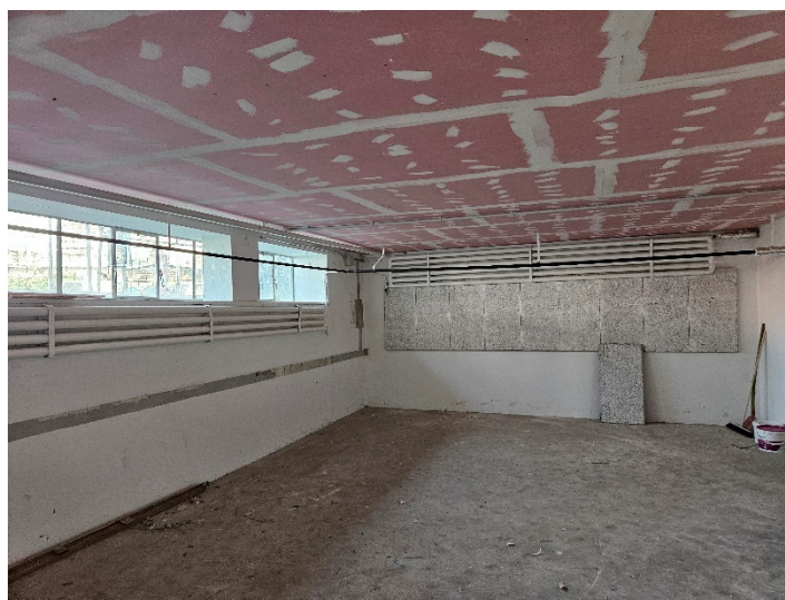
Fertiggestellte Brandschutzunterdecke im Untergeschoss, hier ehemaliger PC Raum, demnächst Ehrengarde;
