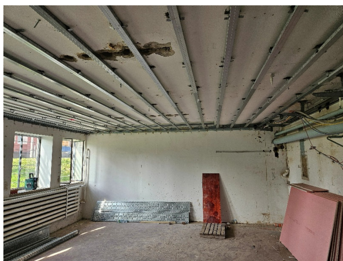
Laufende Arbeiten an der Brandschutzdecke im Untergeschoss, hier Vereinsraum Diaspora Croatica
