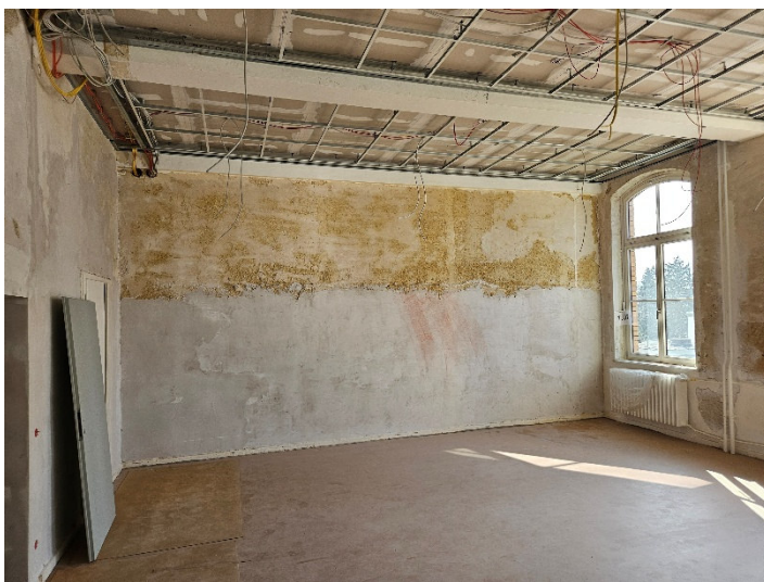
Laufende Putzarbeiten im 2. Obergeschoss
