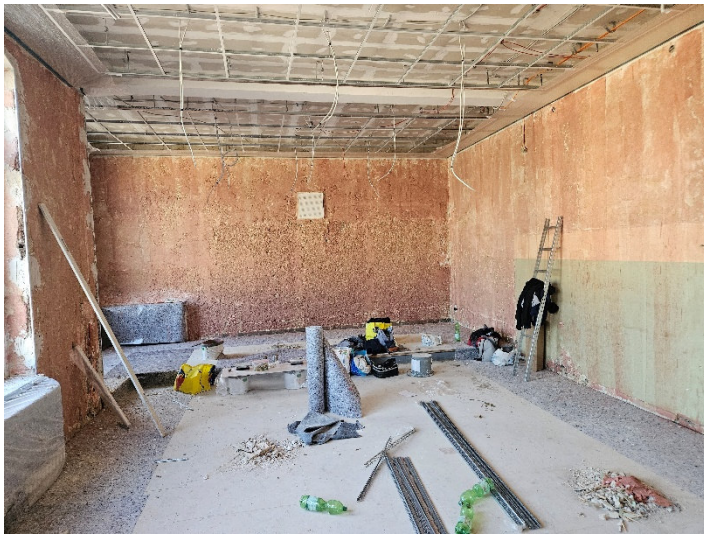
Laufende Putzarbeiten im 2. Obergeschoss
