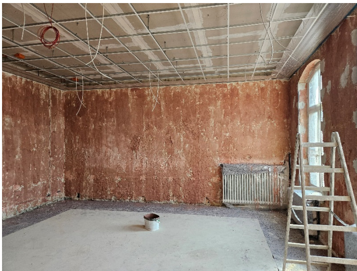
Laufende Putzarbeiten im 2. Obergeschoss
